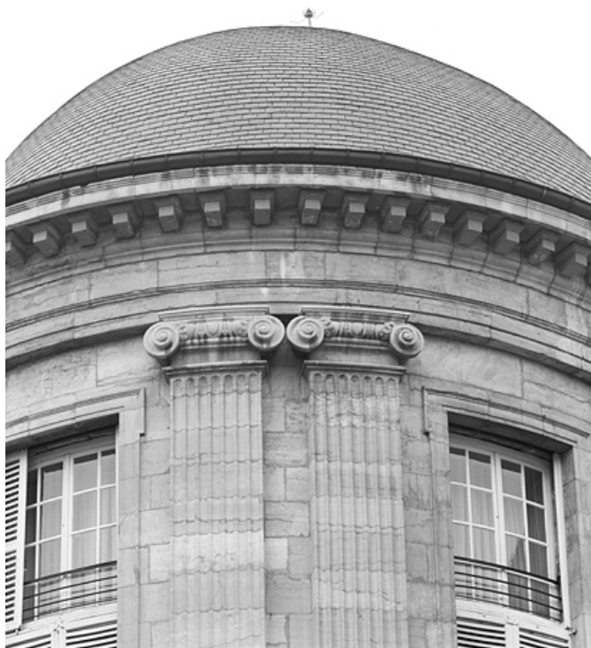
Façade postérieure, ronde : détail des chapiteaux de deux pilastres jumelés. 25, Besançon, 8bis, 10 rue Charles Nodier, lieudit : îlot Préfecture
