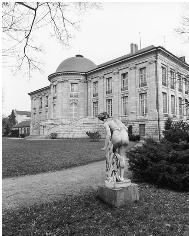
Façade postérieure, de trois quarts droit, avec une statue du parc.
