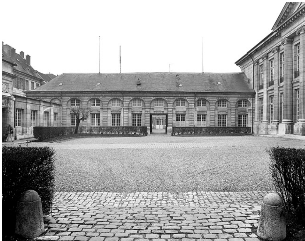
Vue de l'aile gauche sur cour, de face.
