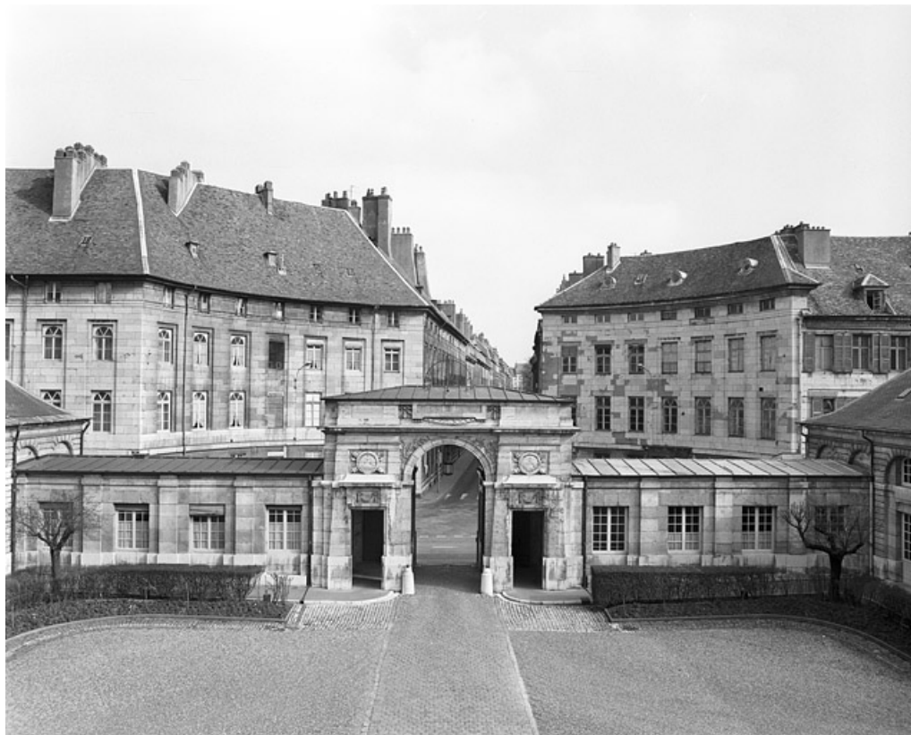
Vue du portail d'entrée depuis l'intérieur de la cour.
