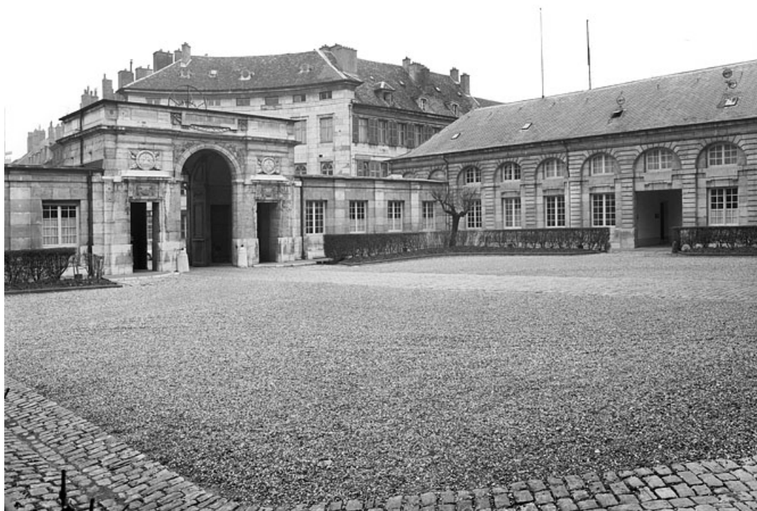
Vue de la cour de trois quarts gauche.
