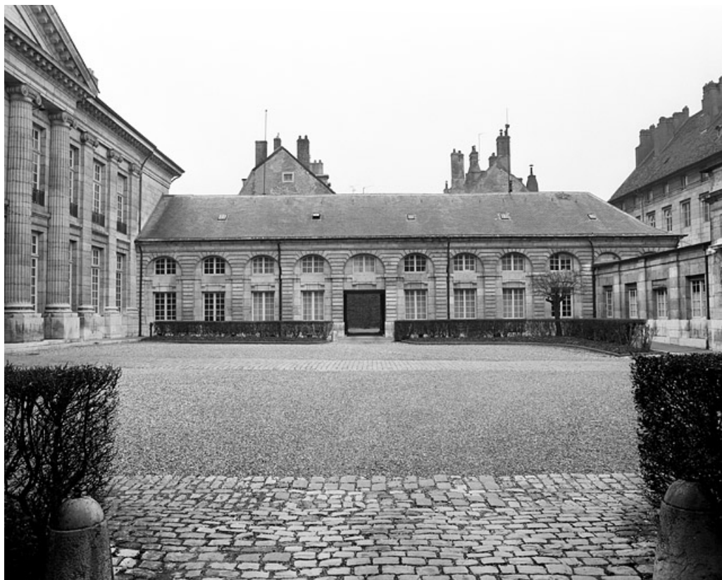
Vue de l'aile droite sur cour, de face.
