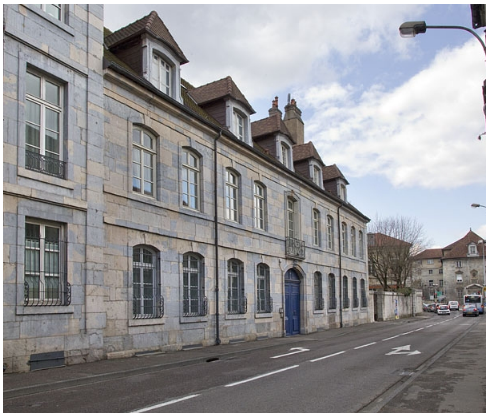
Vue d'ensemble depuis la rue, de trois quarts gauche. 25, Besançon, 2 rue Charles Nodier, lieudit : îlot Préfecture
