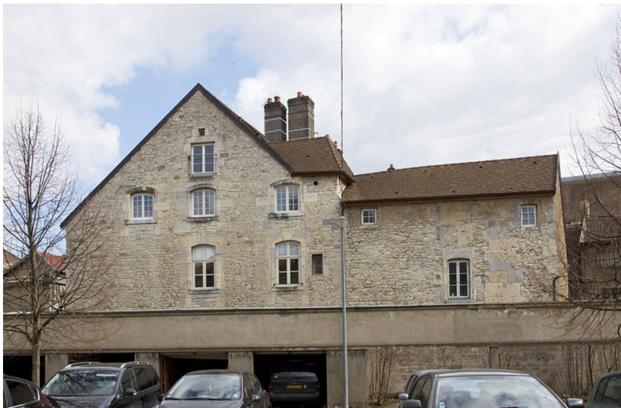
Vue de la façade latérale droite, de face.
