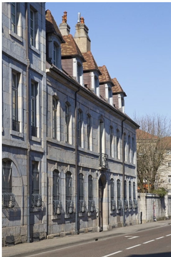
Façade antérieure : vue rapprochée, de trois quarts gauche.
