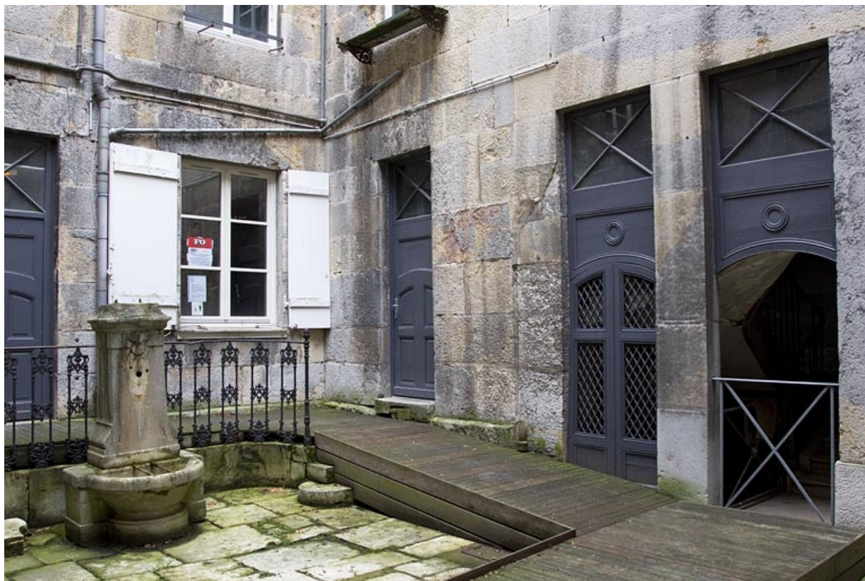
Vue d'une partie de l'aile droite, de trois quarts gauche.
