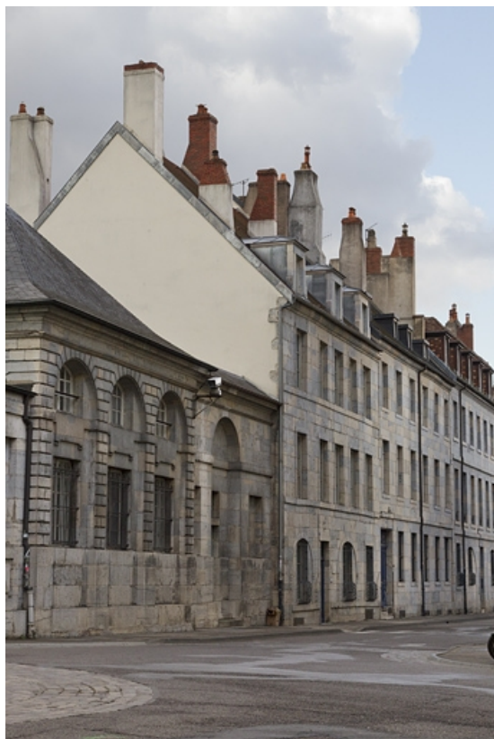
Vue d'ensemble depuis la rue, de trois quarts gauche. 25, Besançon, 8 rue Charles Nodier, lieudit : îlot Préfecture
