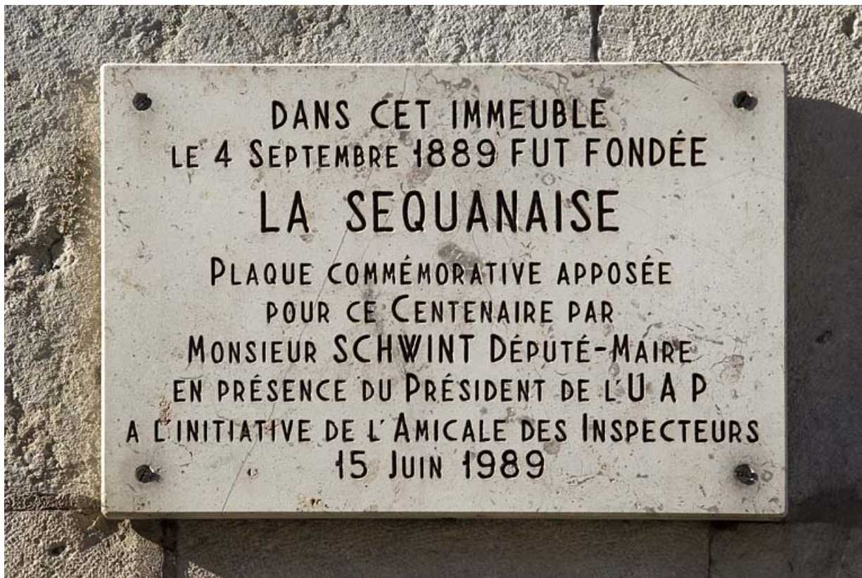
Logis principal, façade antérieure : détail de la plaque commémorative du centenaire de la "Séquanaise". 25, Besançon, 8 rue Charles Nodier, lieudit : îlot Préfecture
