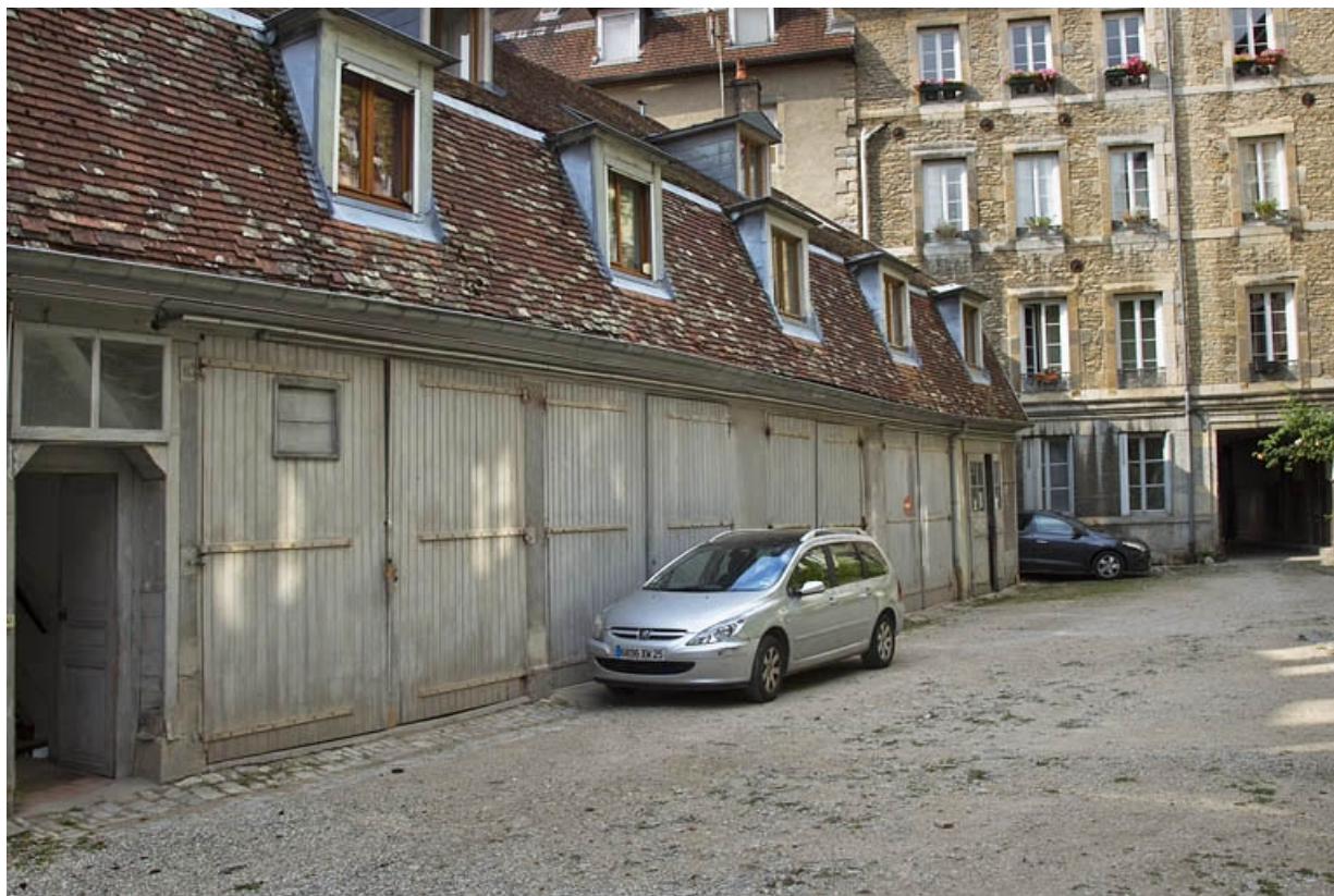
Bâtiment des écuries : vue d'ensemble, de trois quarts gauche.
