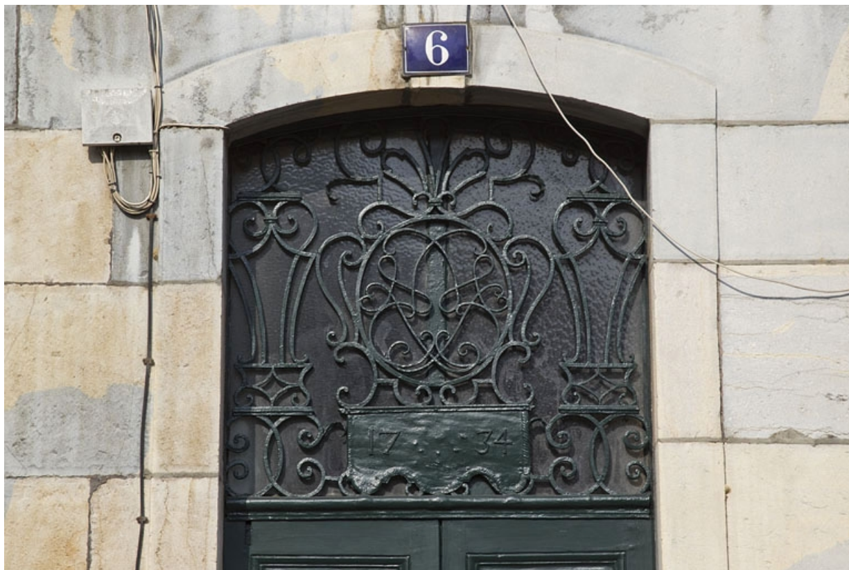
Façade antérieure : détail du dessus de porte en ferronnerie.
