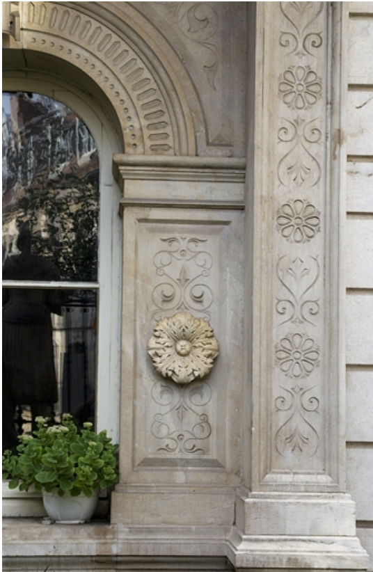
Façade d'angle, baie du rez-de-chaussée : détail du décor de l'encadrement. 25, Besançon, 2 rue Lecourbe, lieudit : îlot Lecourbe
