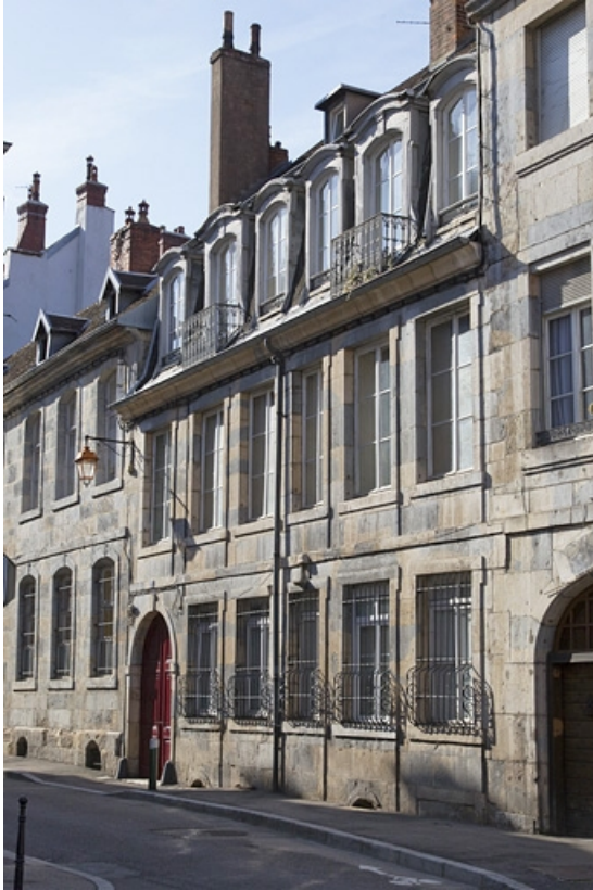
Vue d'ensemble depuis la rue, de trois quarts droit, vue rapprochée.
