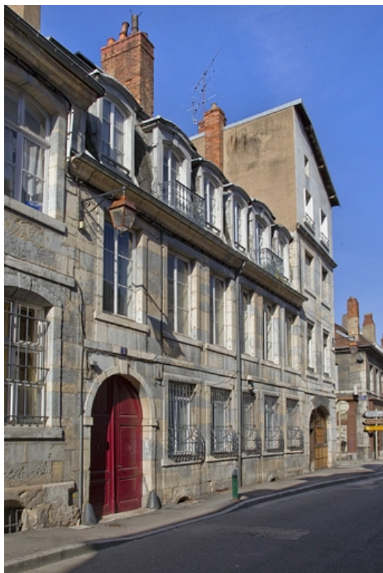
Vue d'ensemble depuis la rue, de trois quarts gauche, vue rapprochée.
