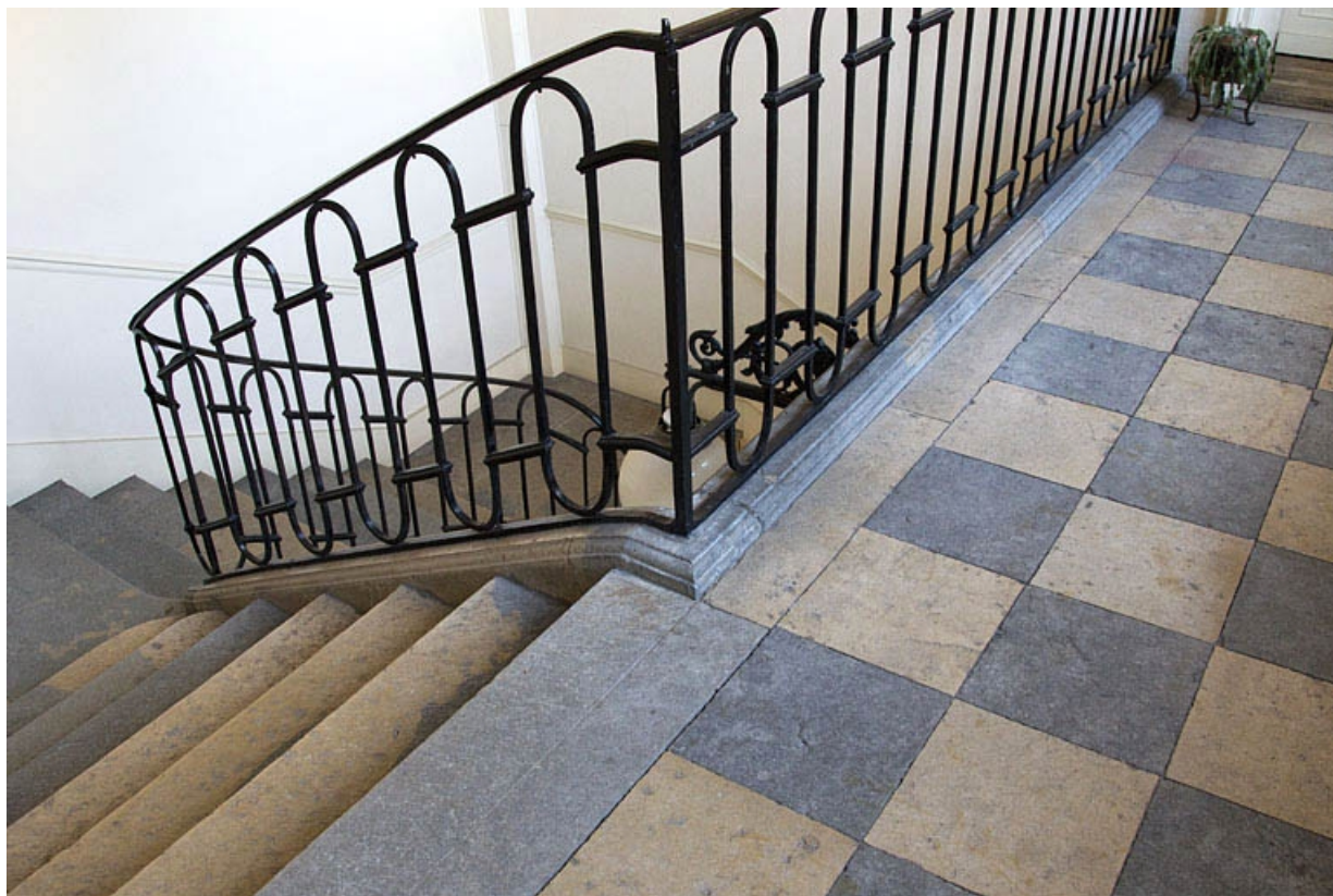
Intérieur, escalier d'honneur : vue de rampe en fer forgé et du dallage du palier.
