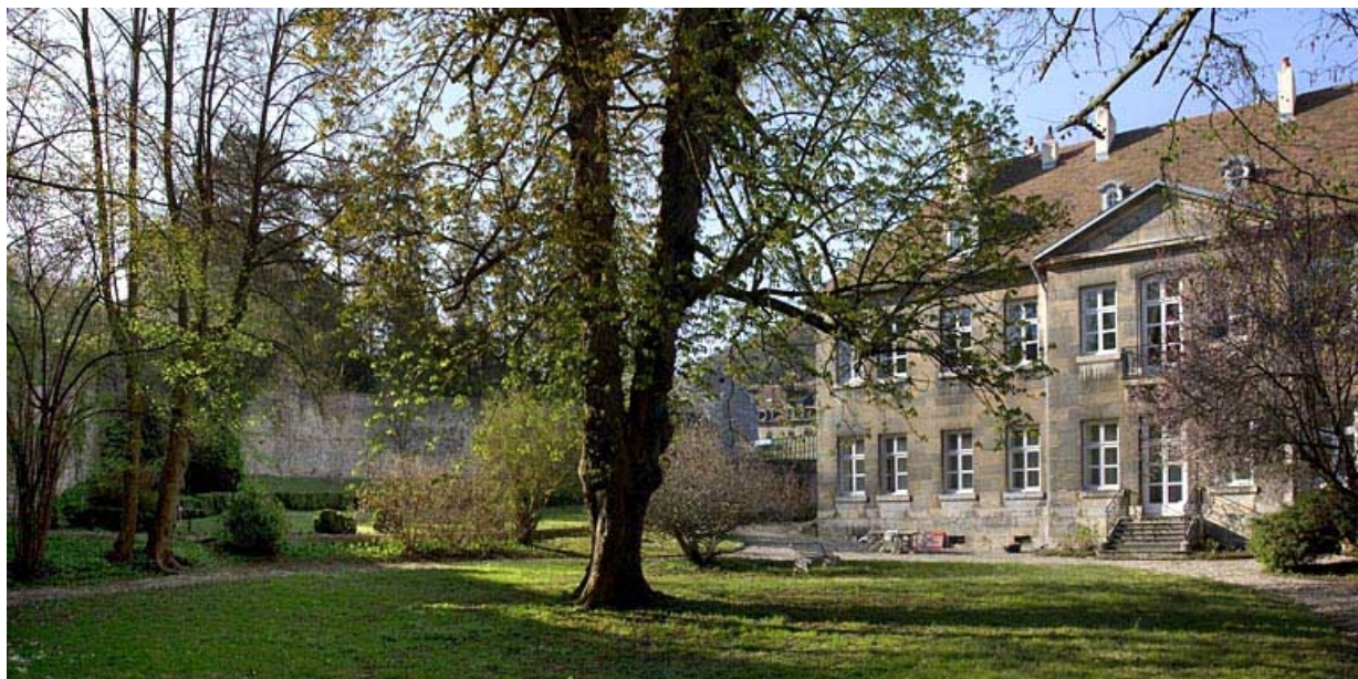
Vue de la partie gauche de la façade postérieure depuis le fond du jardin.
