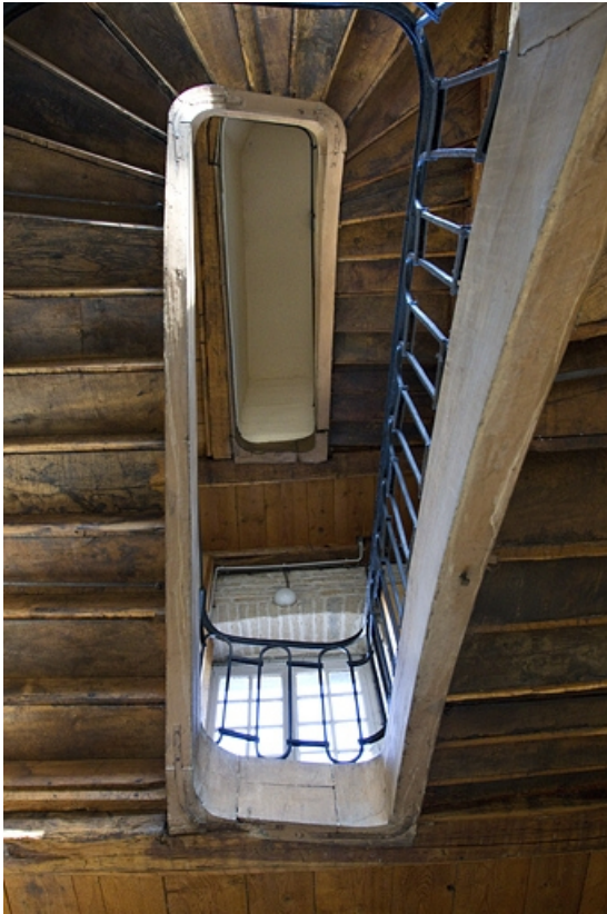
Intérieur : vue de l'escalier secondaire situé dans l'aile droite : en contre plongée.
