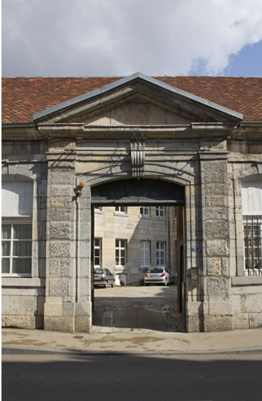
Vue du portail dans clôture : de face.
