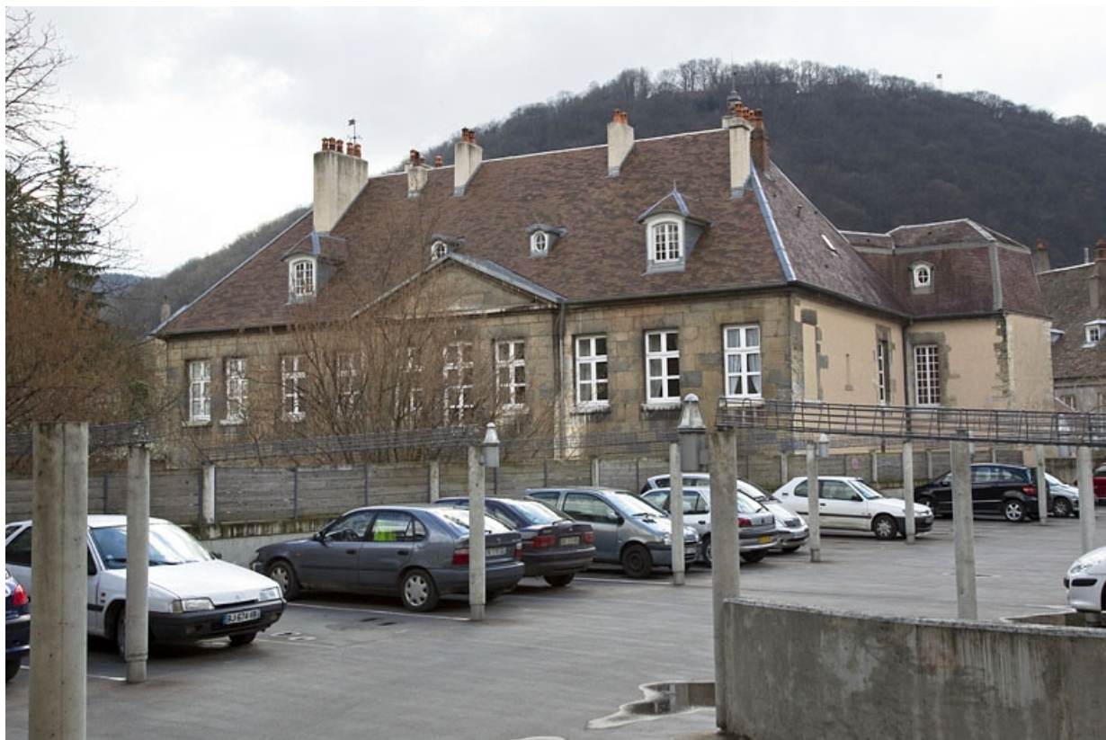
Vue de la façade postérieure depuis l'extérieur, de trois quarts droit.
