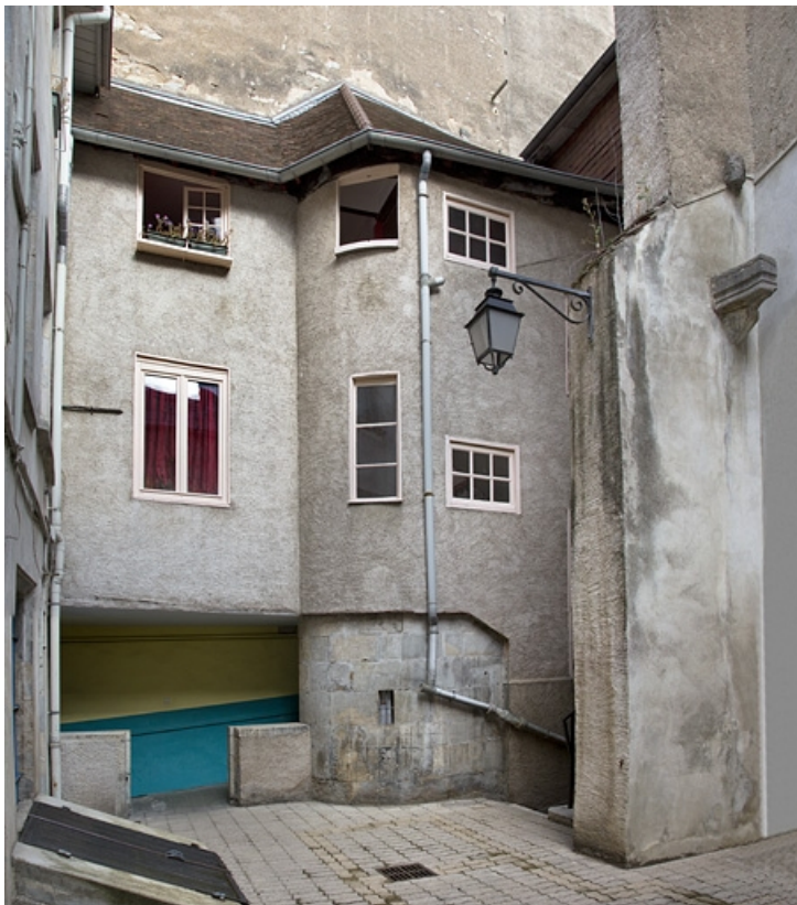
Vue d'ensemble de l'escalier à cage ouverte depuis le fond de la cour, de trois quarts gauche. 25, Besançon, 14 rue de la Vieille Monnaie, lieudit : îlot Refuge
