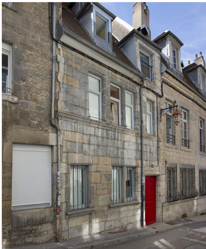
Vue d'ensemble depuis la rue, de trois quarts gauche, vue rapprochée. 25, Besançon, 14 rue de la Vieille Monnaie, lieudit : îlot Refuge
