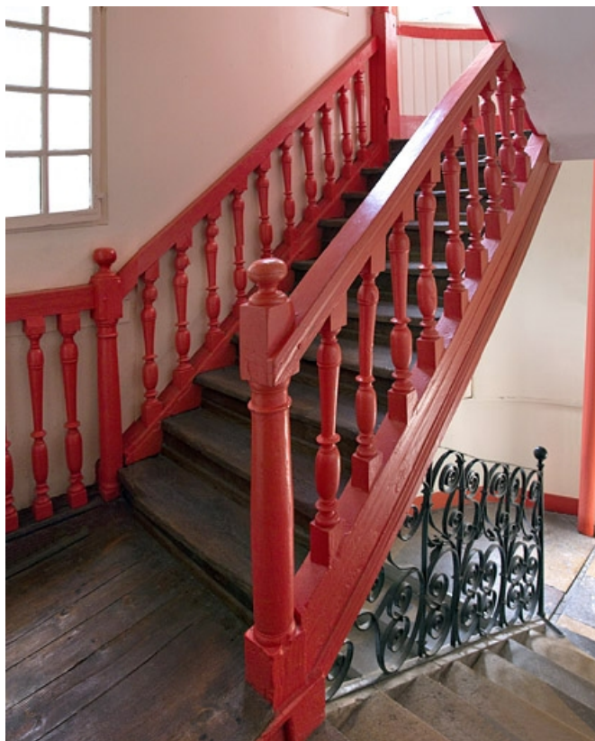
Escalier à cage ouverte : détail de la rampe en ferronnerie, puis à balustres de bois tourné. 25, Besançon, 14 rue de la Vieille Monnaie, lieudit : îlot Refuge
