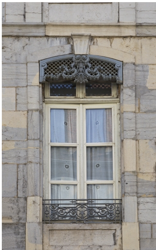
Logis principal, façade antérieure : détail d'une fenêtre du premier étage.
