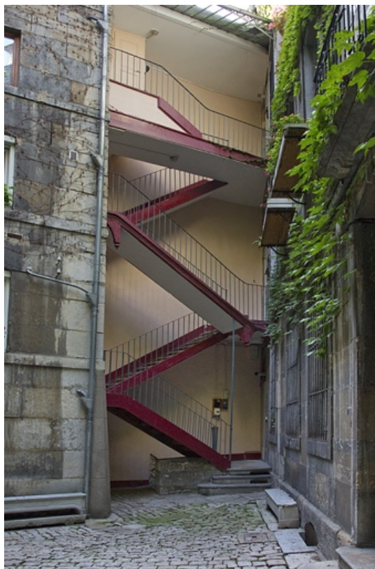
Vue d'ensemble de l'escalier à cage ouverte sur cour, de face.
