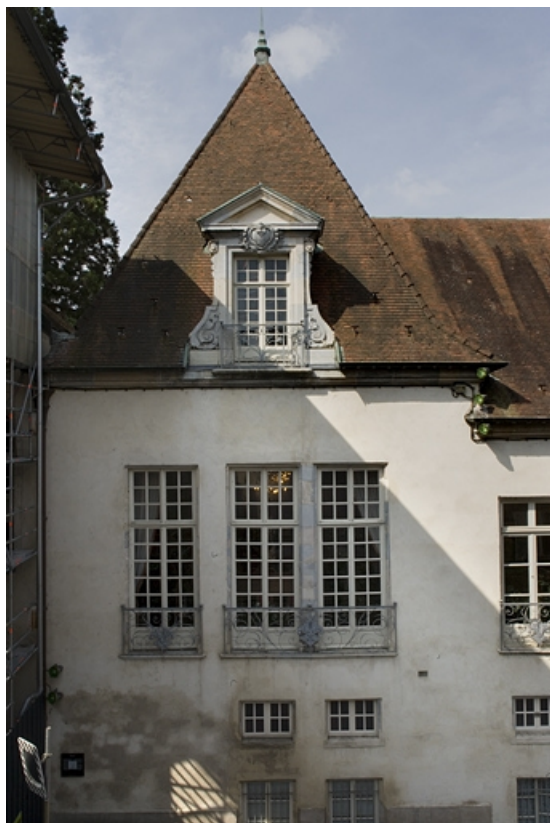
Détail de la partie supérieure de l'avant-corps gauche, vue rapprochée.
