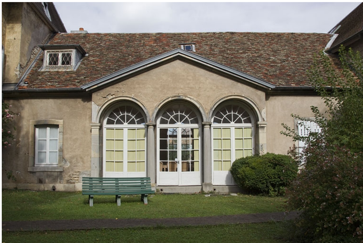
Orangerie : vue d'ensemble de la façade postérieure.
