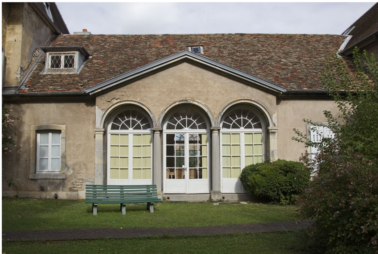
Orangerie : vue d'ensemble de la façade postérieure.
