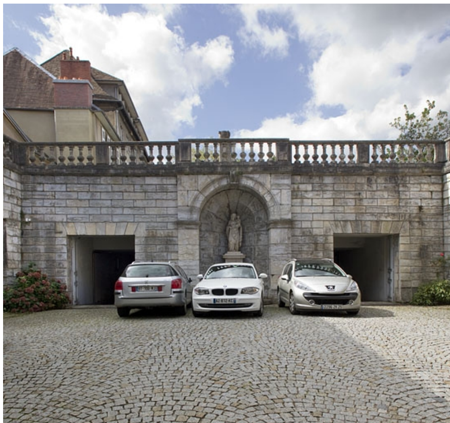
Vue d'ensemble du soubassement de la terrasse au fond de la cour, de face.
