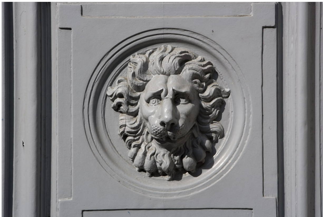
Détail d'une tête de lion sur un vantail du portail d'entrée.
