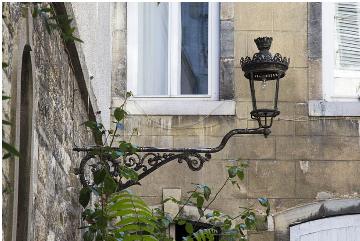
Détail d'un bec de gaz situé dans la cour.
