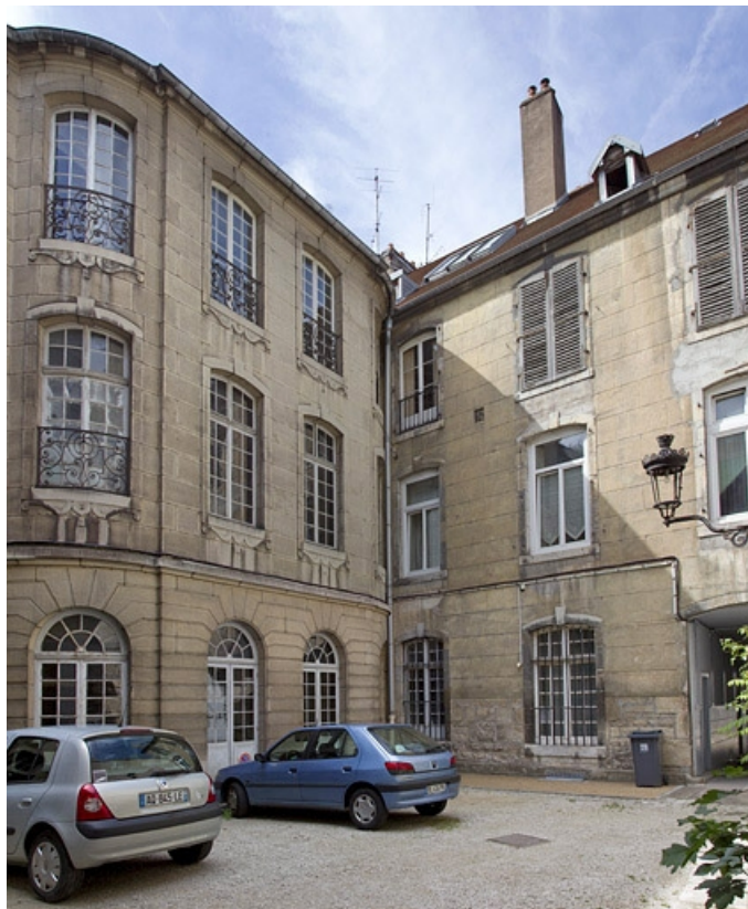
Logis principal : détail de la façade postérieure et de l'aile droite de l'escalier, de trois quarts gauche. 25, Besançon, 25 rue Renan, lieudit : îlot Cingle
