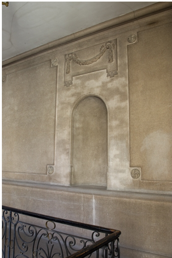
Aile de l'escalier : détail du décor de la cage. 25, Besançon, 25 rue Renan, lieudit : îlot Cingle
