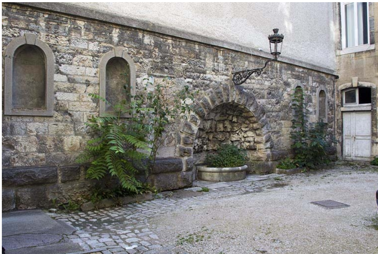
Mur gauche de la cour : vue d'ensemble.
