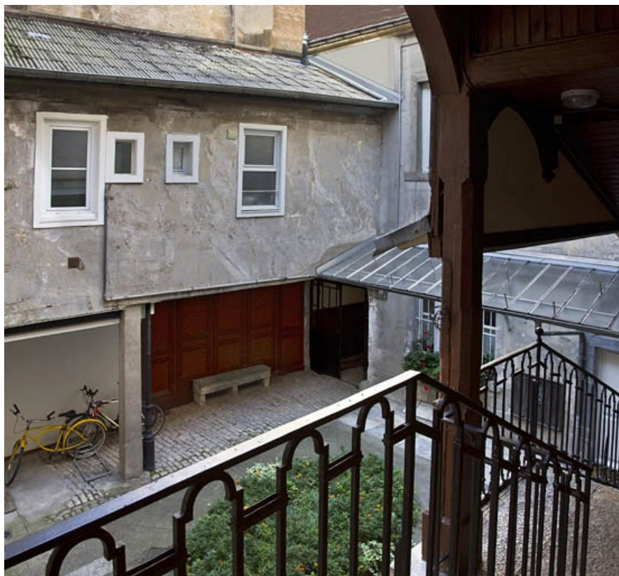
Vue d'ensemble de la cour depuis l'escalier à cage ouverte.
