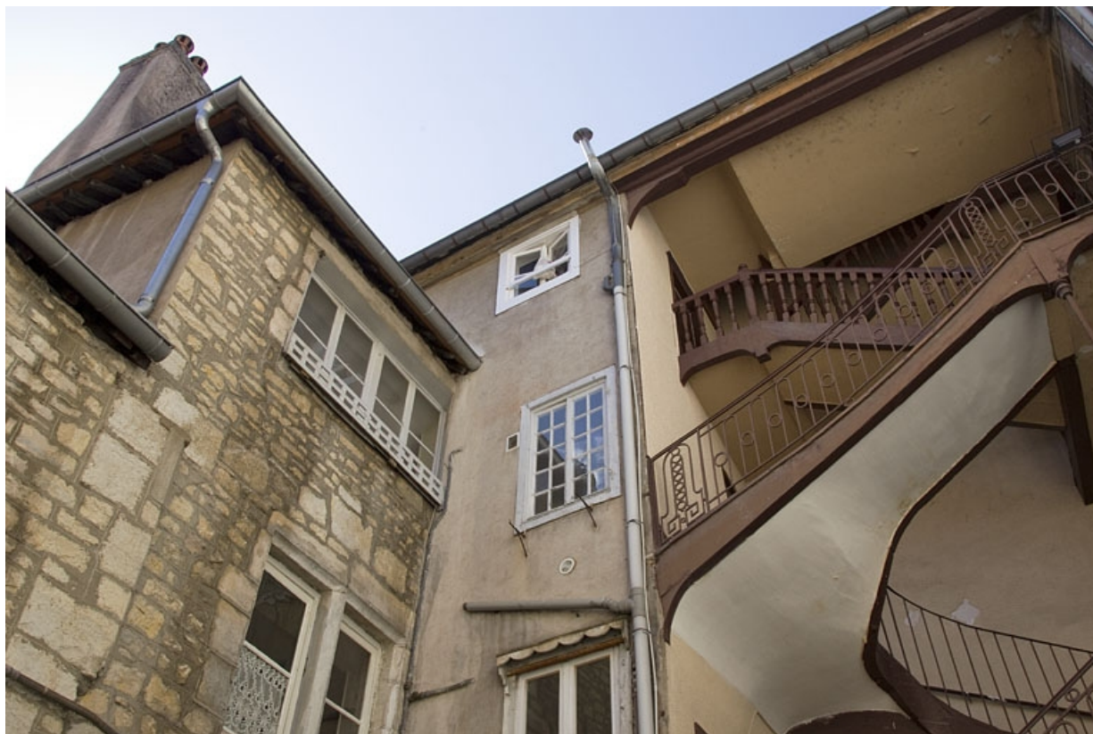
Logis secondaire et escalier à cage ouverte : détail des parties supérieures.
