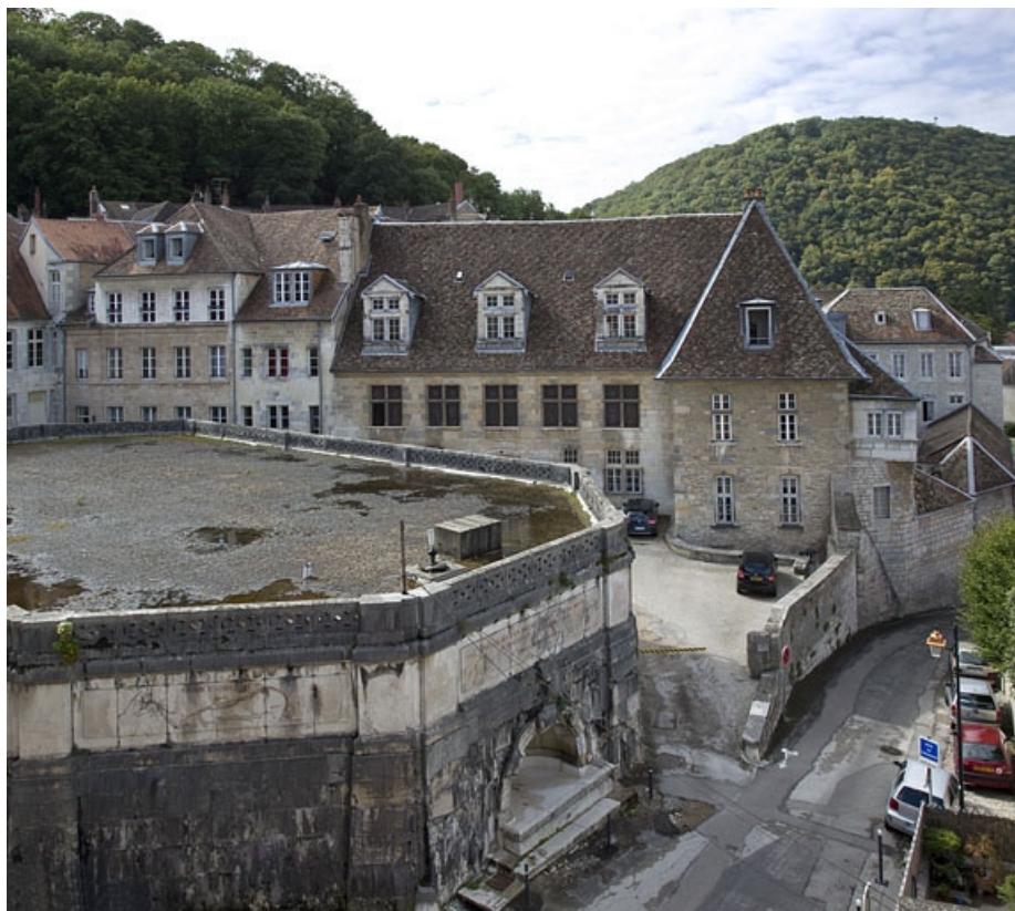
Vue d'ensemble de l'édifice depuis une fenêtre du vieil archevêché.
