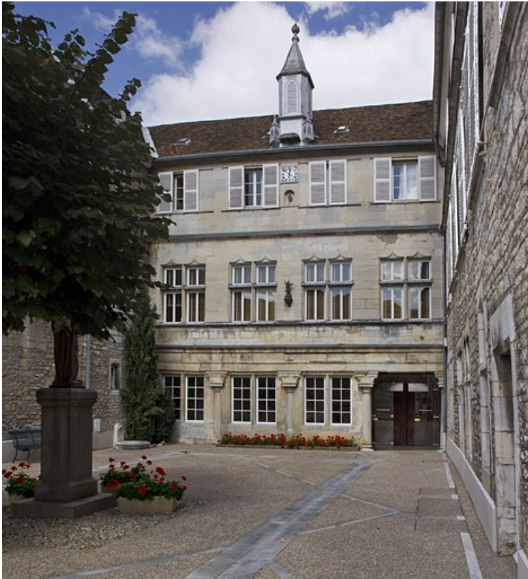
Logis principal : vue de la façade postérieure. 25, Besançon, 6 rue du Palais, lieudit : îlot Cingle
