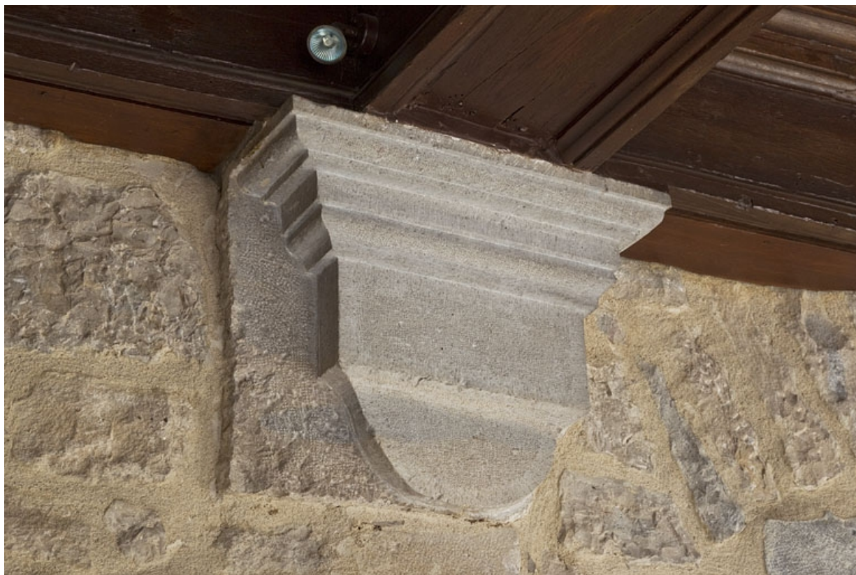
Logis principal, intérieur du portique : détail d'une console supportant le plafond.
