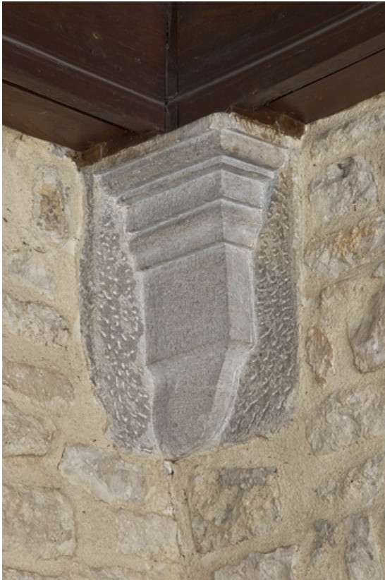
Logis principal, portique : détail d'une console supportant le plafond.
