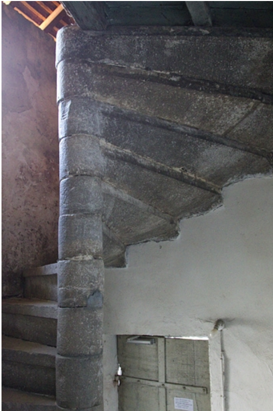
Deuxième logis secondaire : détail d'escalier en vis.
