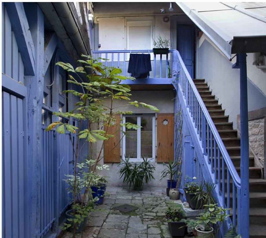
Deuxième logis secondaire, façade postérieure : détail de l'escalier extérieur. 25, Besançon, 31 rue Renan, lieudit : îlot Cingle
