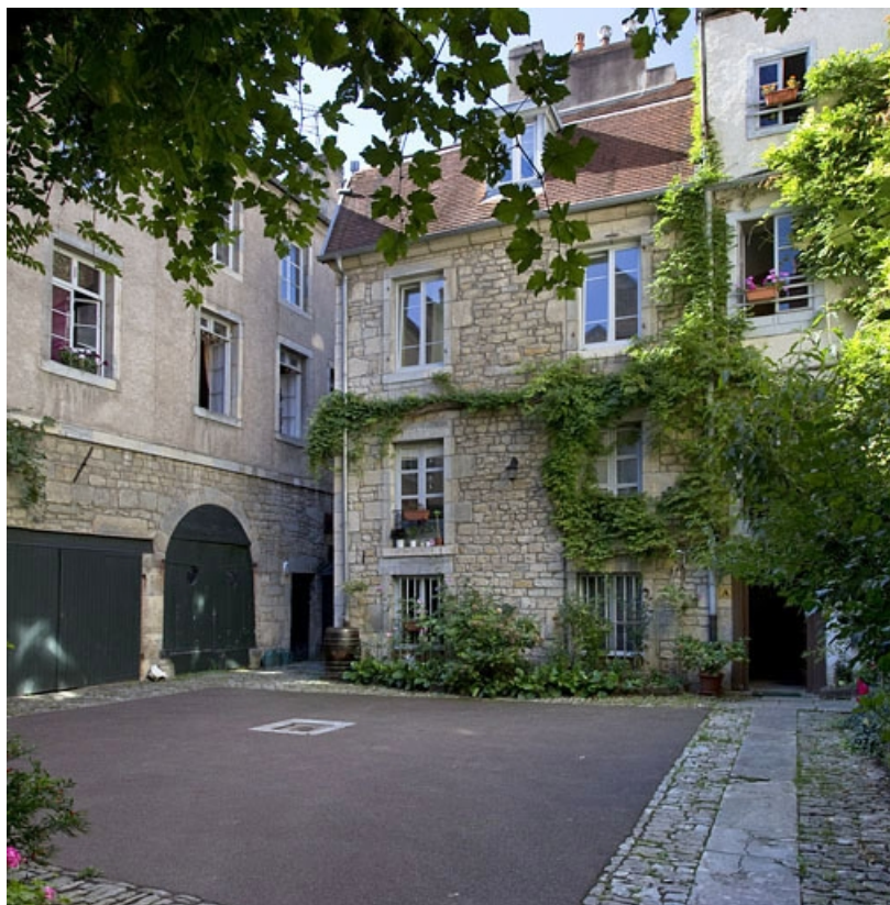
Vue d'ensemble du premier logis secondaire, depuis l'entrée de la cour.
