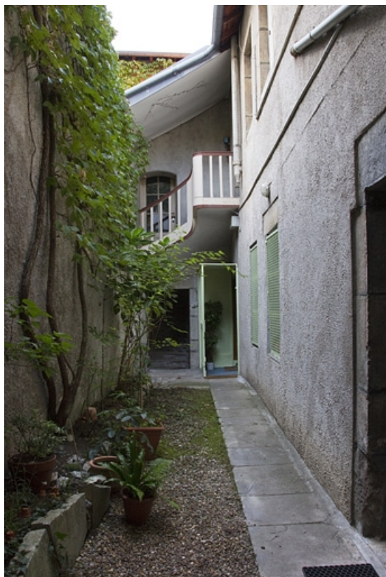
Deuxième logis secondaire : détail de la façade postérieure depuis l'entrée de la deuxième courette.
