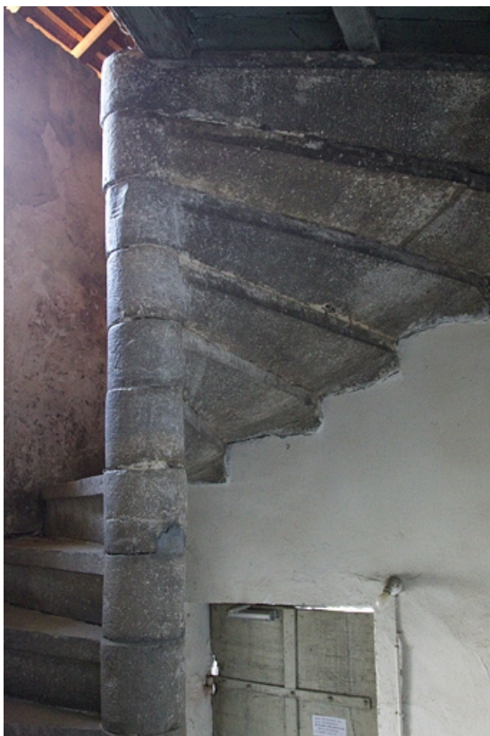
Deuxième logis secondaire : détail d'escalier en vis.
