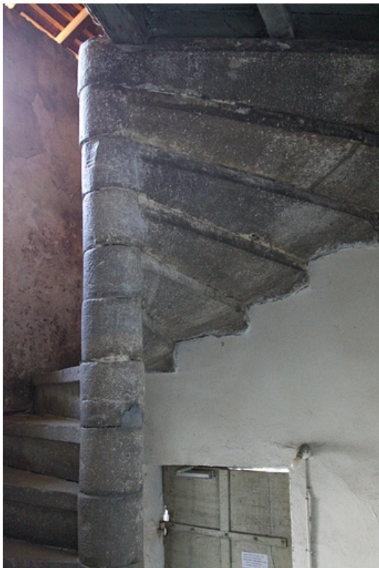
Deuxième logis secondaire : détail d'escalier en vis.
