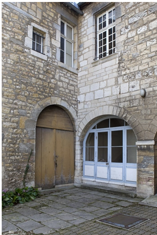
Détail de l'angle gauche entre l'aile gauche et le logis en fond de cour.
