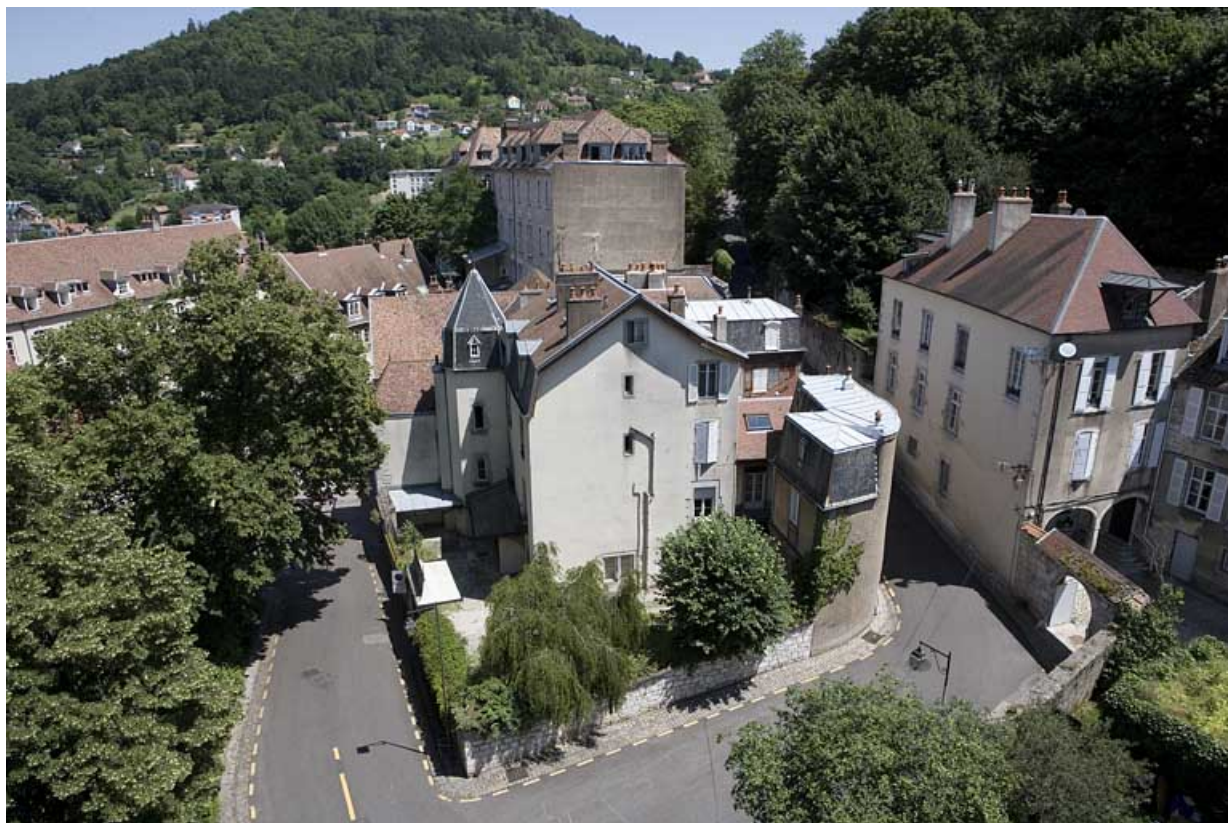
Vue plongeante sur la demeure depuis le clocher de la cathédrale Saint-Jean. 25, Besançon, 12 rue de la Convention, lieudit : îlot Boitouset
