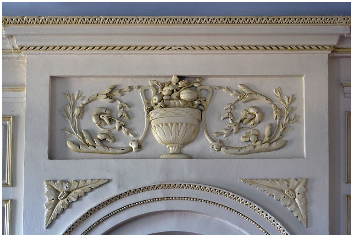
Intérieur : chambre, détail du décor au-dessus de la niche du poêle. 25, Besançon, 11 rue de la Convention, lieudit : îlot Boitouset
