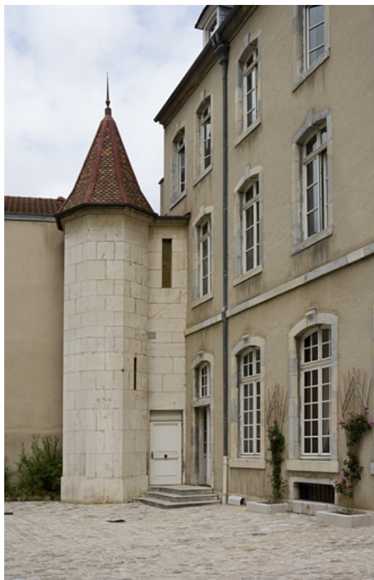
Façade antérieure, détail de la tour d'escalier, vue éloignée.
