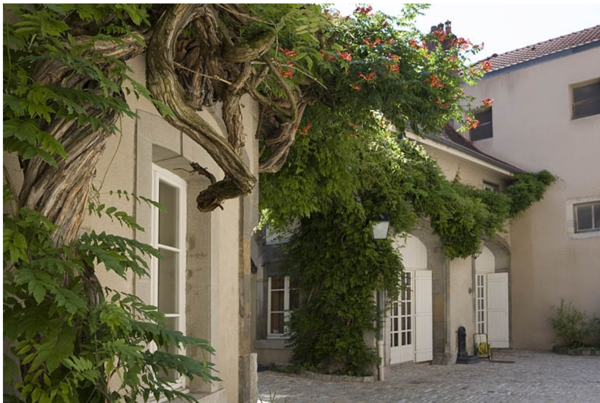
Détail des communs, vue rapprochée de trois quarts gauche.
