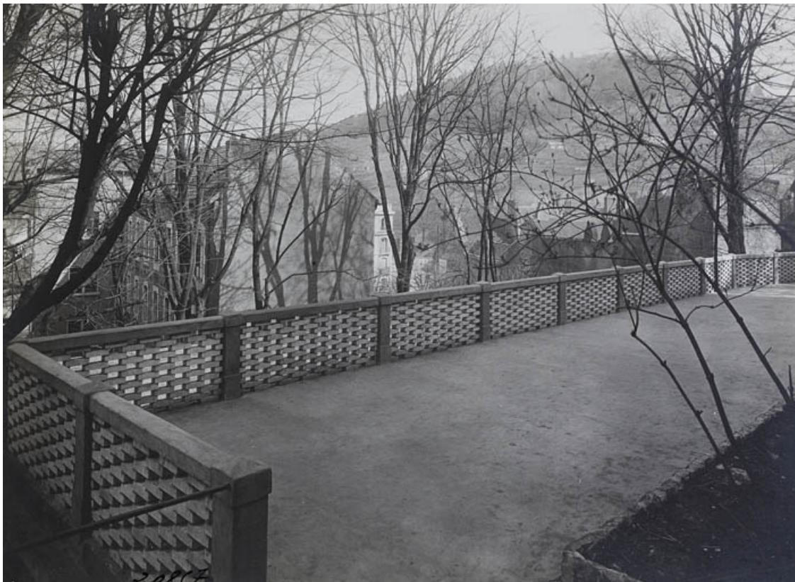
Photographie ancienne montrant la terrasse (disparue) derrière l'édifice.
