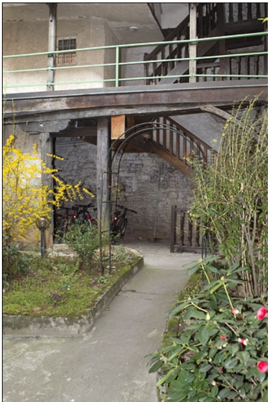
Vue de l'escalier à cage ouverte à droite de la première cour.
