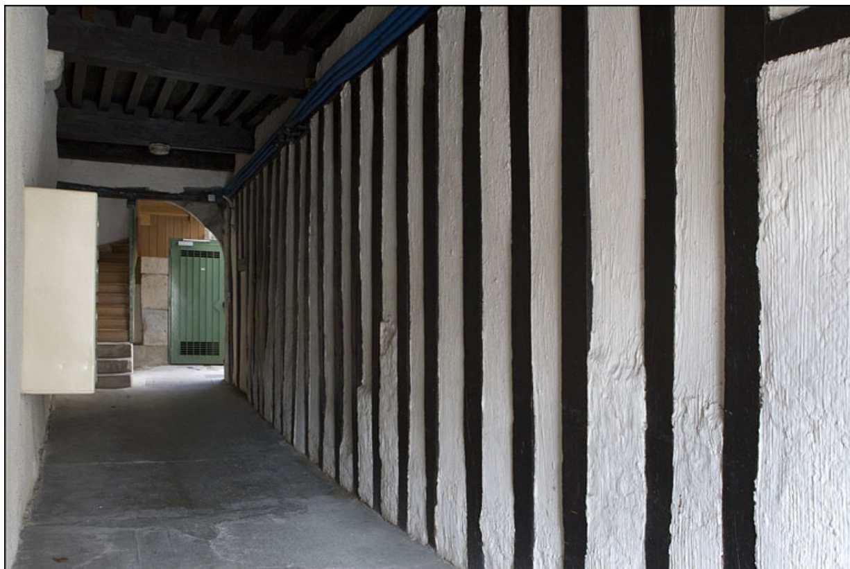
Vue du mur latéral droit, en pan de bois, du passage cocher.
