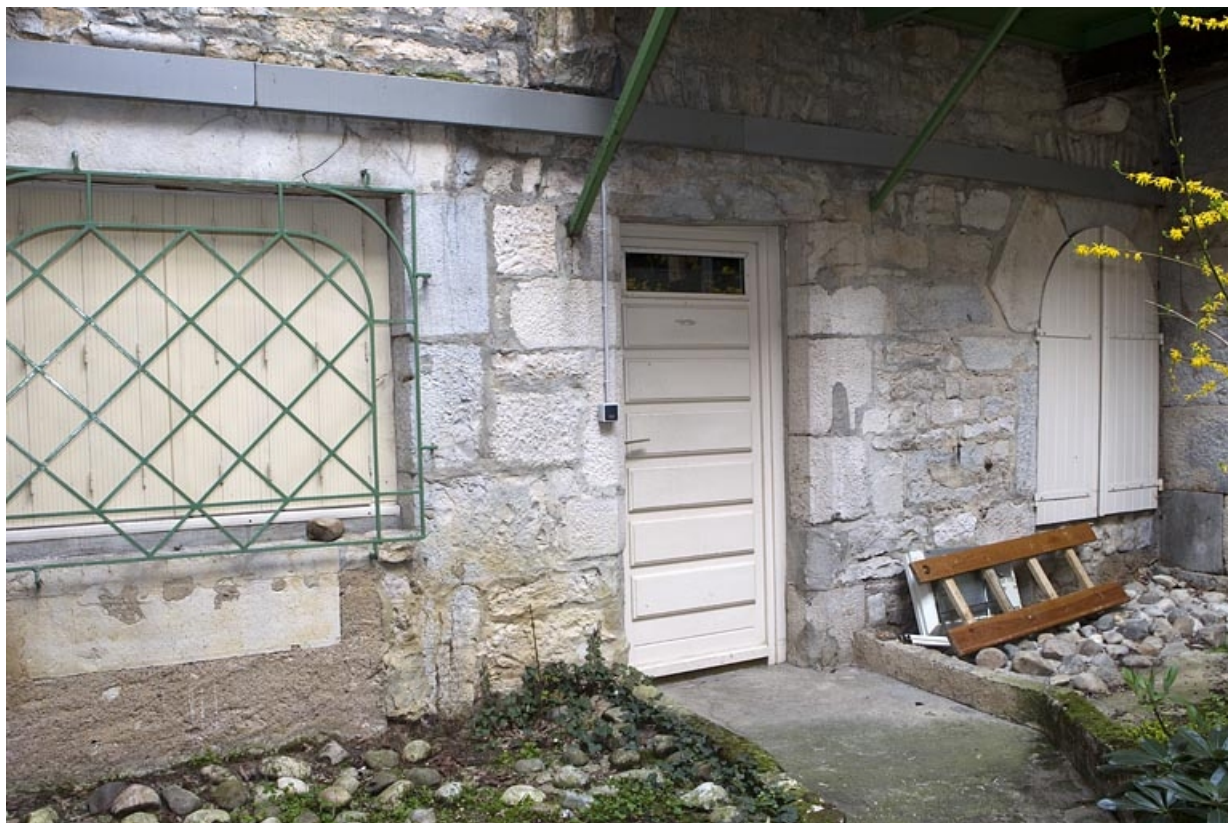
Façade antérieure du logis secondaire : détail du rez-de-chaussée.
