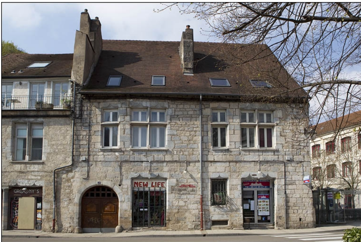
Vue d'ensemble du logis principal depuis la rue, de face.
