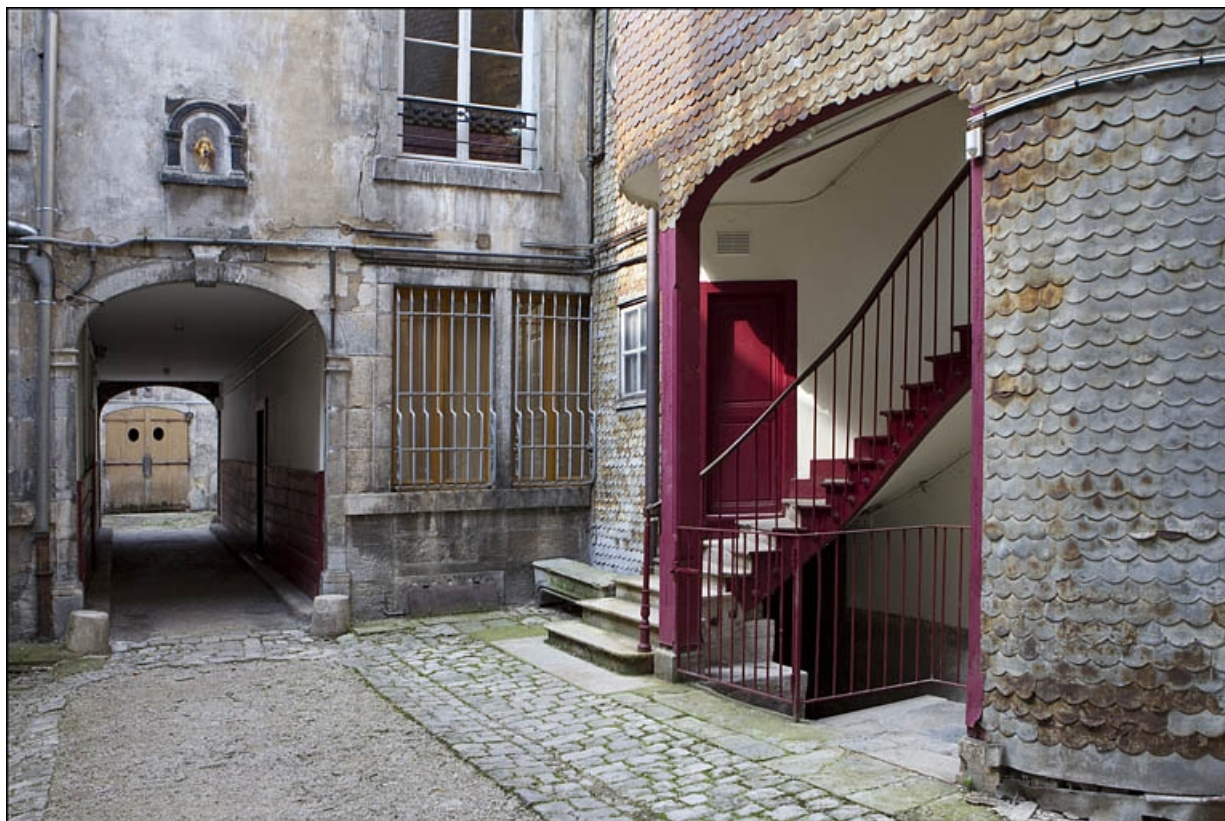
Détail du départ de l'escalier à cage ouverte et du deuxième passage cocher, depuis l'entrée de la première cour. 25, Besançon, 22 rue Rivotte, lieudit : îlot Boitouset
