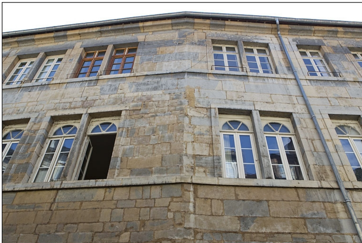
Façade antérieure sur rue du logis principal : vue des premier et second étages.
