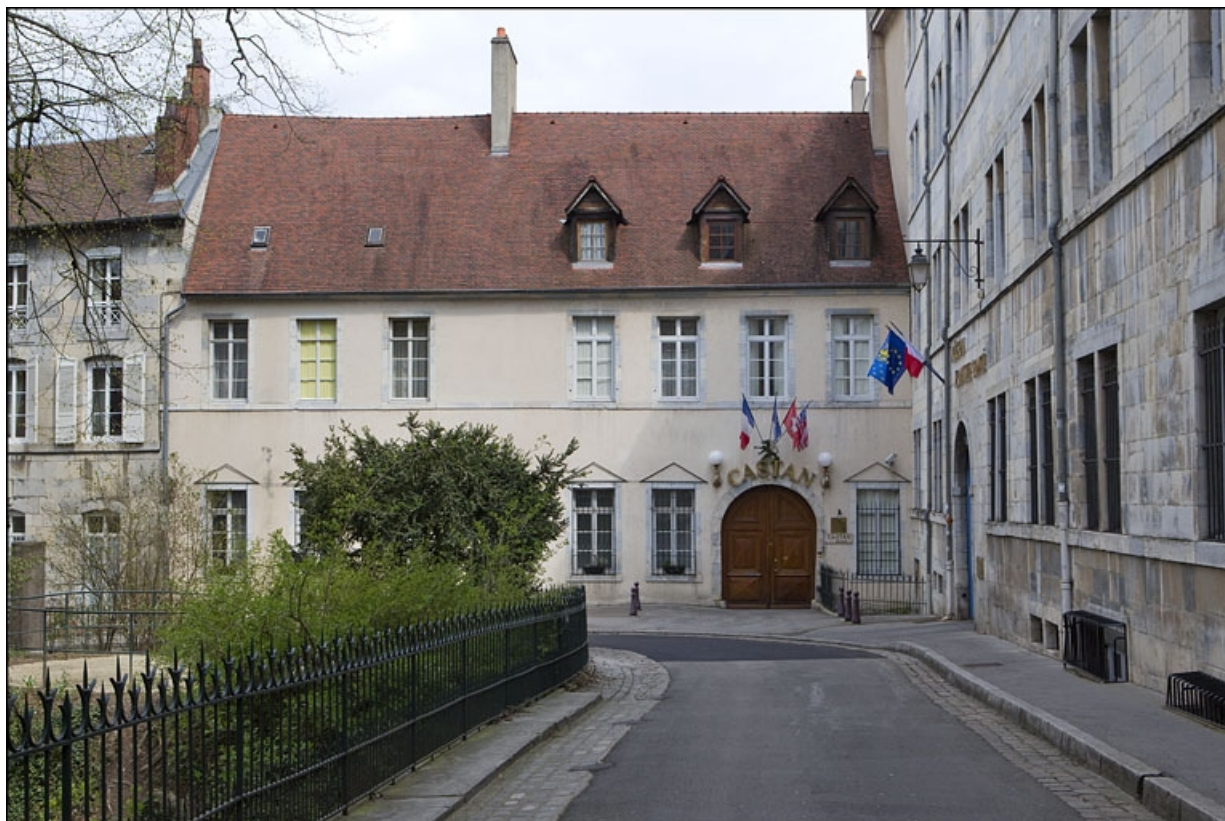
Vue d'ensemble de la façade antérieure du logis principal depuis la rue.
