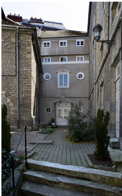
Vue d'ensemble du bâtiment en fond de cour antérieure depuis la rue.
