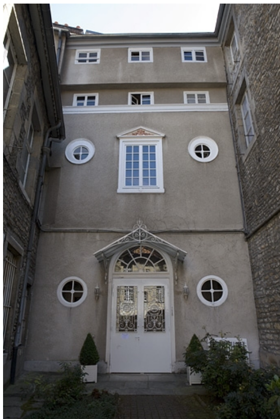
Vue d'ensemble de la façade du bâtiment au fond de la cour.
