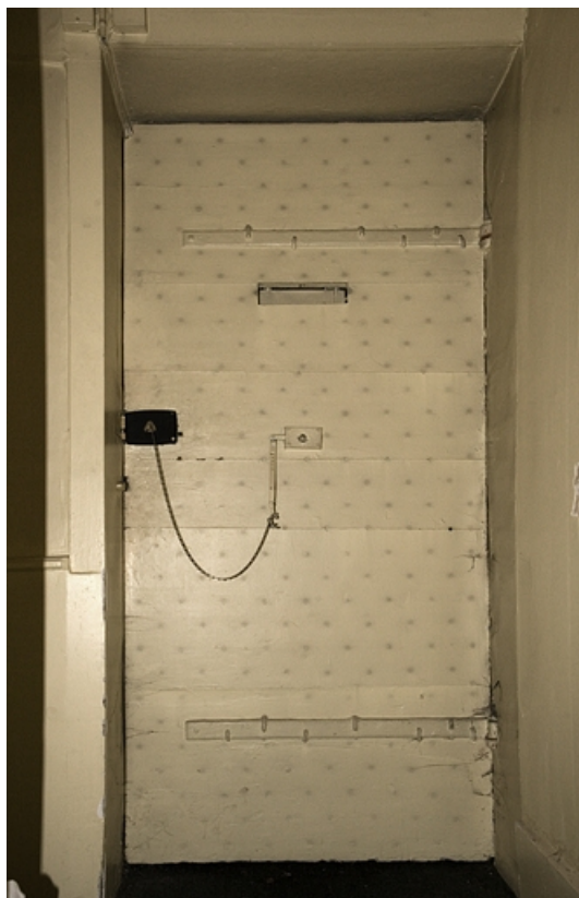
Intérieur, rez-de-chaussée : détail de la porte d'entrée du bâtiment à gauche de la cour. 25, Besançon, 2 rue Pécelet, lieudit : îlot Boitouset
