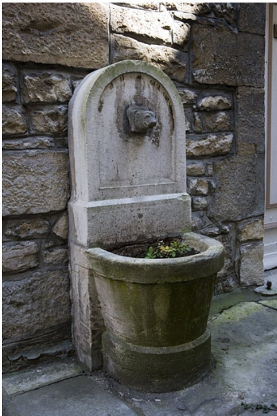
Détail de la borne fontaine à gauche de la cour. 25, Besançon, 2 rue Pécelet, lieudit : îlot Boitouset
