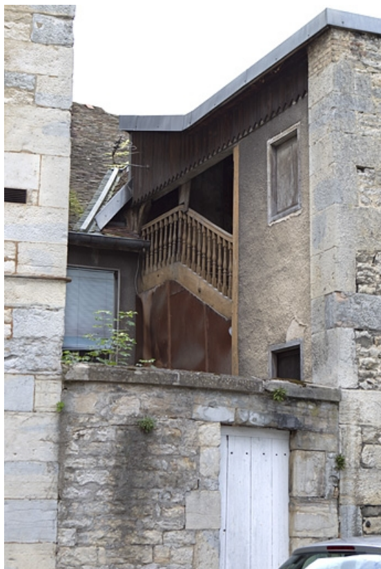
Détail de l'escalier à cage ouverte depuis la cour de l'hôtel Alviset.
