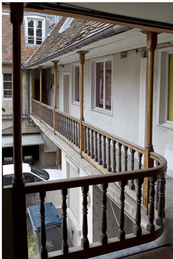
Détail de galerie sur cour du logis principal depuis le haut de l'escalier.
