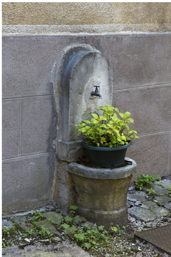
Détail de la borne fontaine dans la première cour. 25, Besançon, 7 rue Pécelet, lieudit : îlot des Martelots
