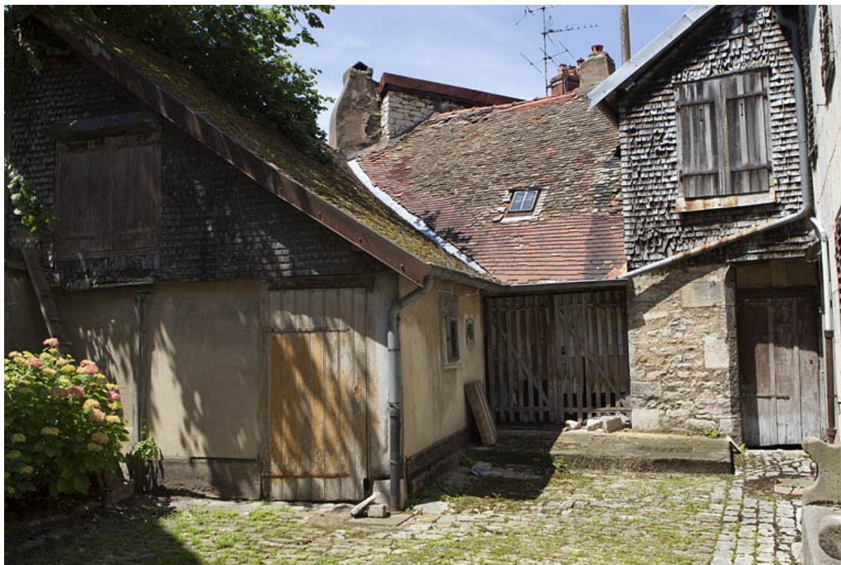
Vue d'ensemble des petits bâtiments et du bûcher au fond de la deuxième cour.
