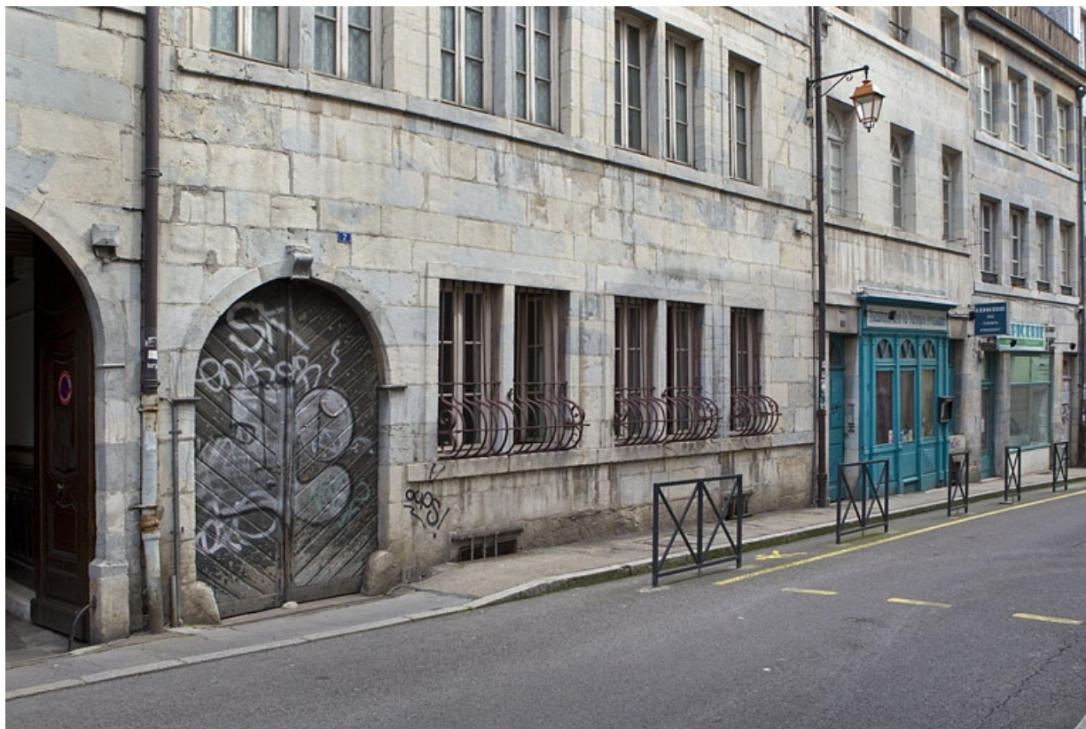
Façade sur rue du logis principal : détail du rez-de-chaussée.
