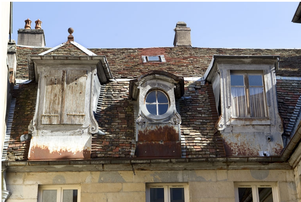
Toit du premier logis secondaire sur la première cour : détail des lucarnes.
