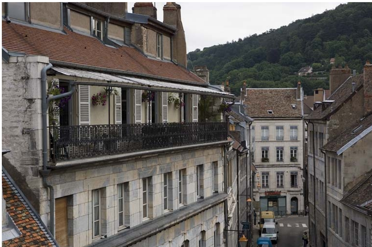
Vue du deuxième étage sur rue et de la surélévation.
