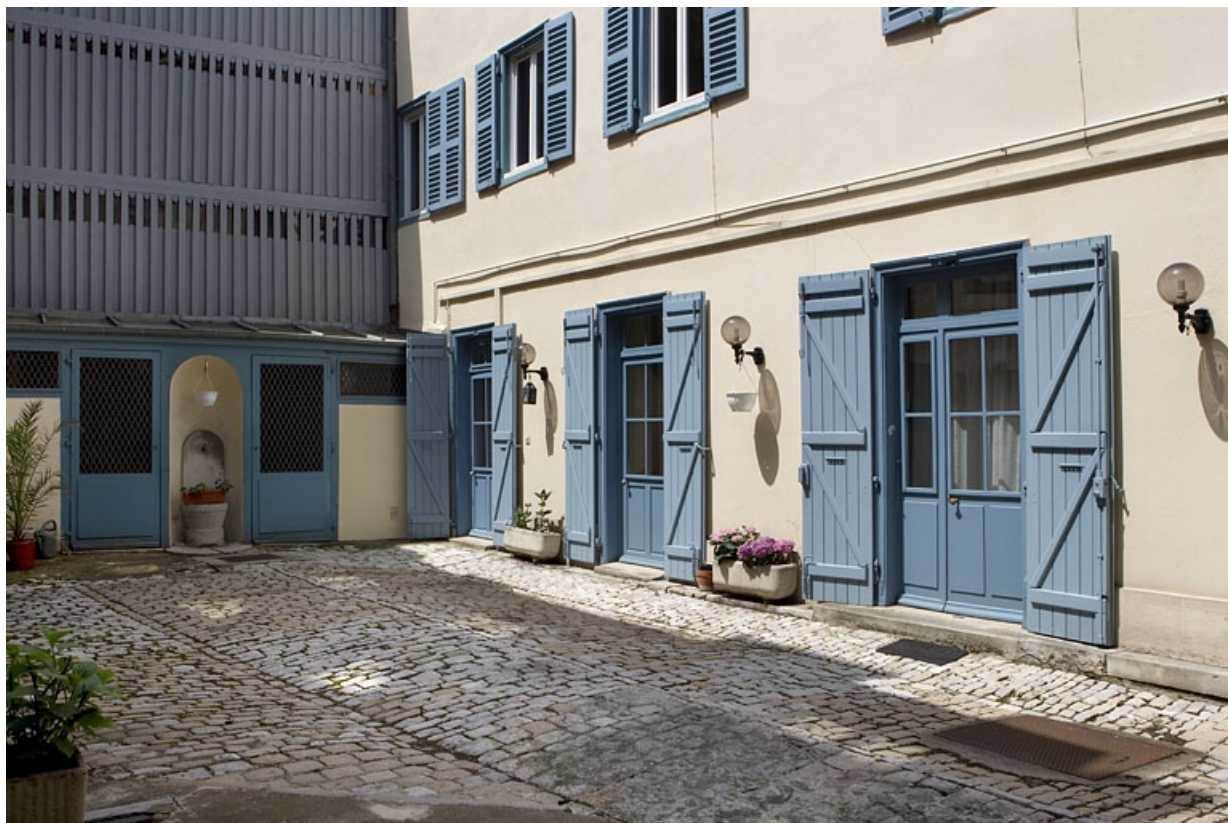
Détail du rez-de-chaussée du logis secondaire droit et d'une partie du séchoir.
