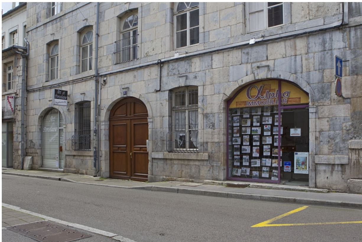
Détail du rez-de-chaussée de la façade sur rue du logis principal, de trois quarts droit. 25, Besançon, 6 rue de Pontarlier, lieudit : îlot des Martelots
