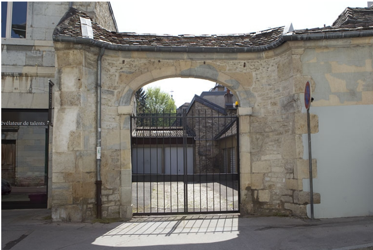
Vue d'ensemble de l'entrée secondaire de l'hôtel, de face.
