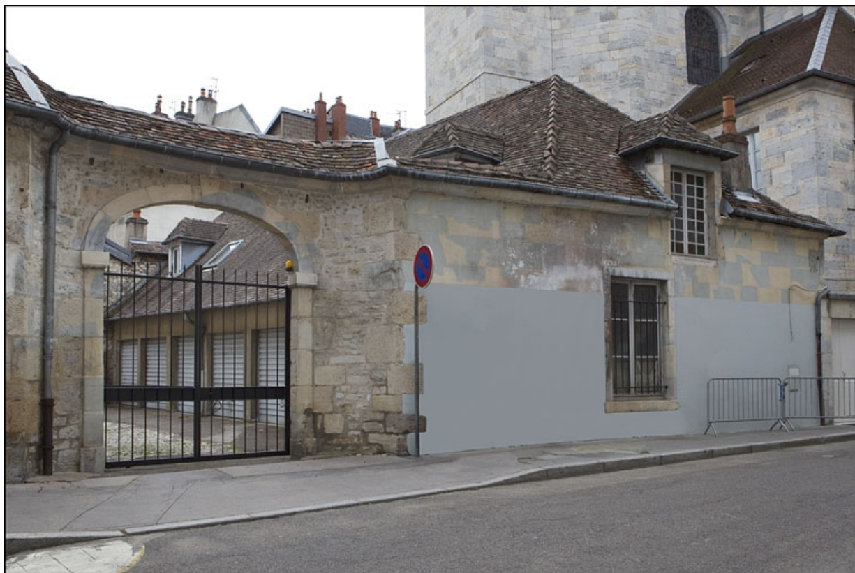
Vue d'ensemble de l'entrée secondaire de l'hôtel, de trois quarts gauche.
