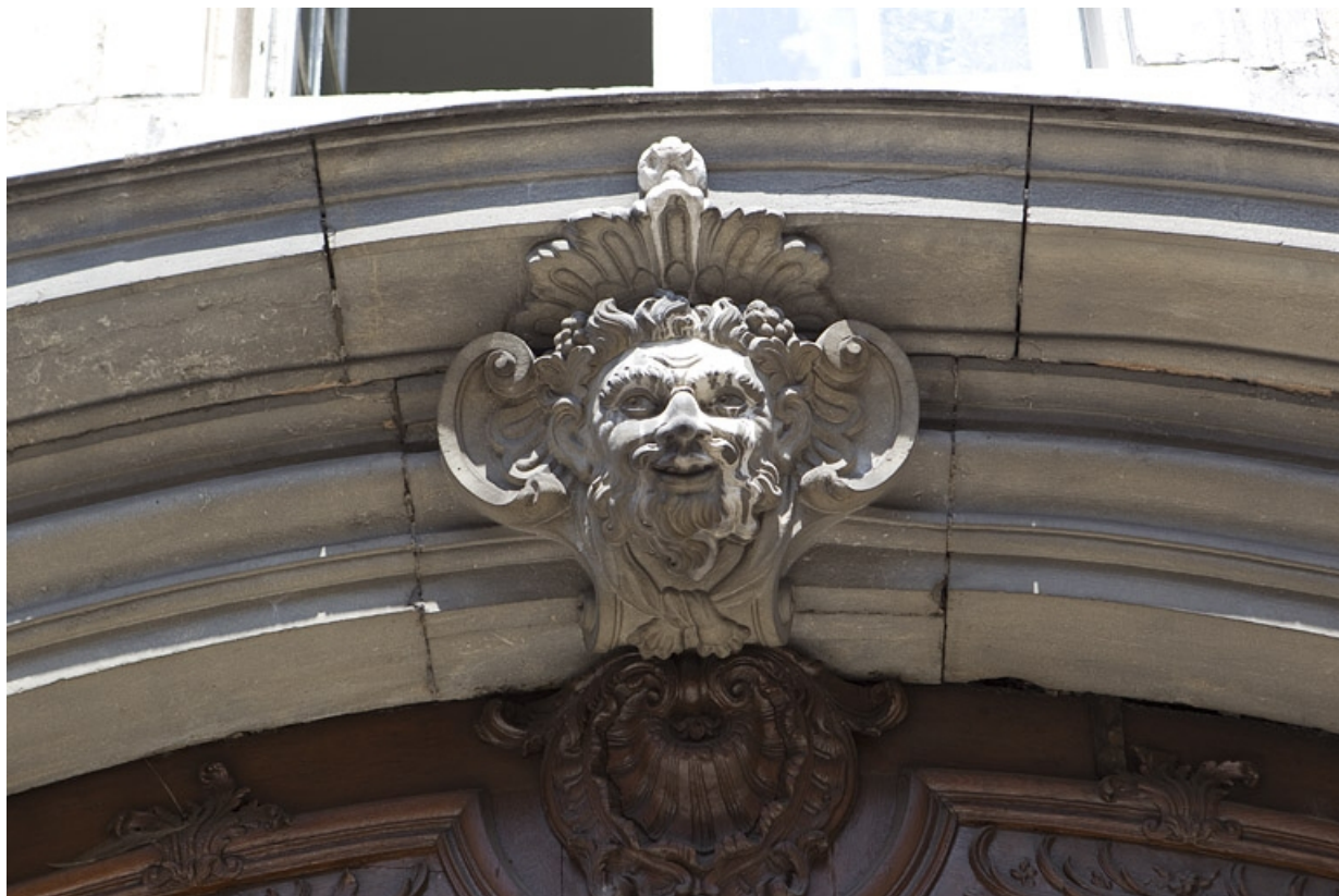
Façade antérieure sur rue, détail de la clé sur l'arc du portail d'entrée.
