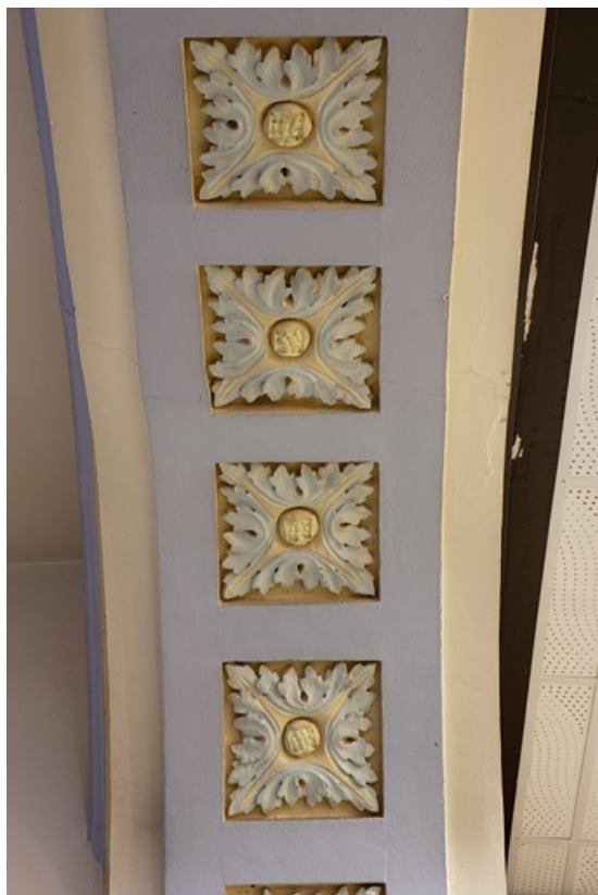
Intérieur, détail du décor de l'intrados de l'arc séparant l'escalier de l'ancien passage cocher. 25, Besançon, 127 Grande Rue, lieudit : îlot Saint-Maurice
