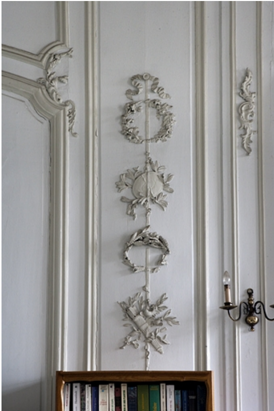
Intérieur, premier étage, pièce donnant sur la cour : détail d'un décor de lambris à panneau étroit. 25, Besançon, 127 Grande Rue, lieudit : îlot Saint-Maurice
