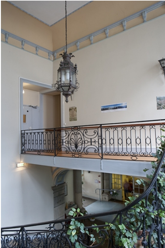
Intérieur, escalier : détail du grand palier au premier étage. 25, Besançon, 127 Grande Rue, lieudit : îlot Saint-Maurice
