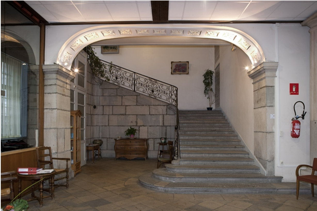
Intérieur : vue d'ensemble de l'escalier à gauche de l'ancien passage cocher. 25, Besançon, 127 Grande Rue, lieudit : îlot Saint-Maurice
