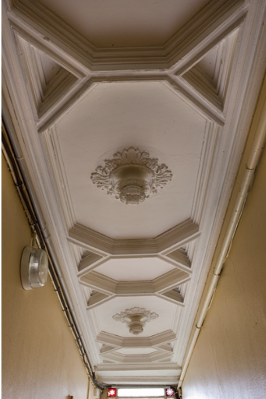
Logis principal : détail du plafond du couloir d'entrée. 25, Besançon, 137 Grande Rue, lieudit : îlot Saint-Maurice
