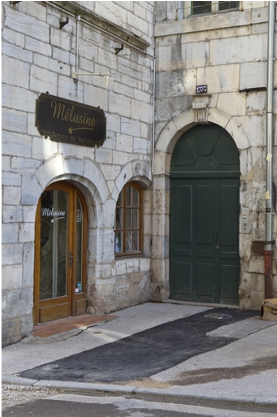
Logis principal, façade sur rue : détail des baies du rez-de-chaussée dans l'angle du bâtiment. 25, Besançon, 135 Grande Rue, lieudit : îlot Saint-Maurice
