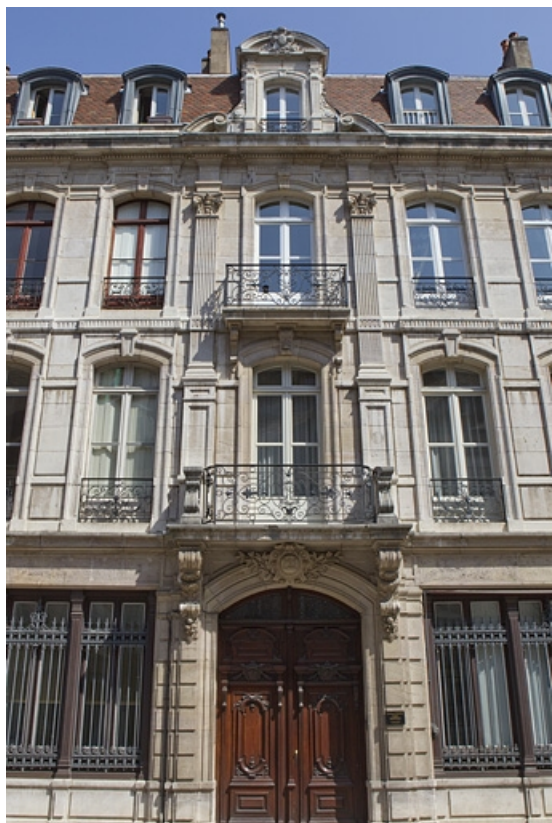
Détail de la travée centrale de la façade antérieure avec le portail d'entrée. 25, Besançon, 121 Grande Rue, lieudit : îlot Saint-Maurice
