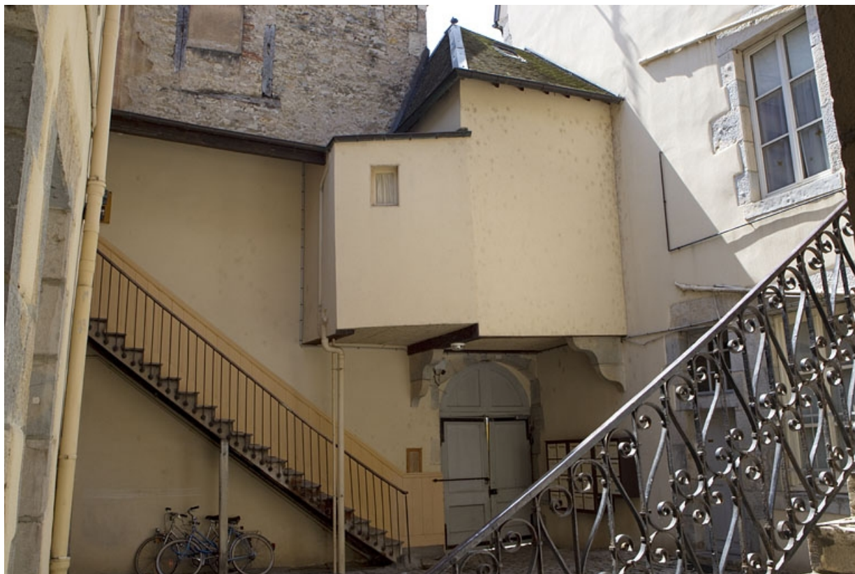
Vue d'ensemble de l'escalier extérieur secondaire situé dans la première cour.
