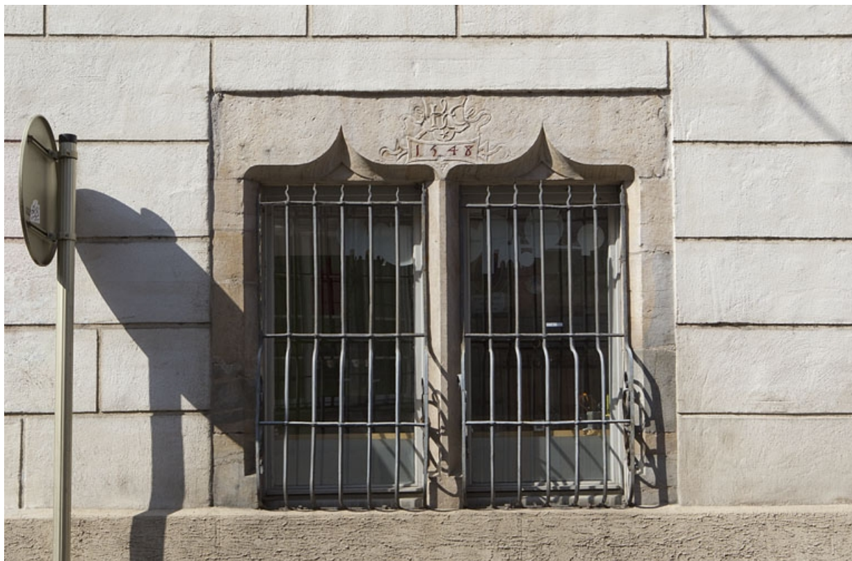
Façade latérale droite : détail d'une baie en accolade du rez-de-chaussée.
