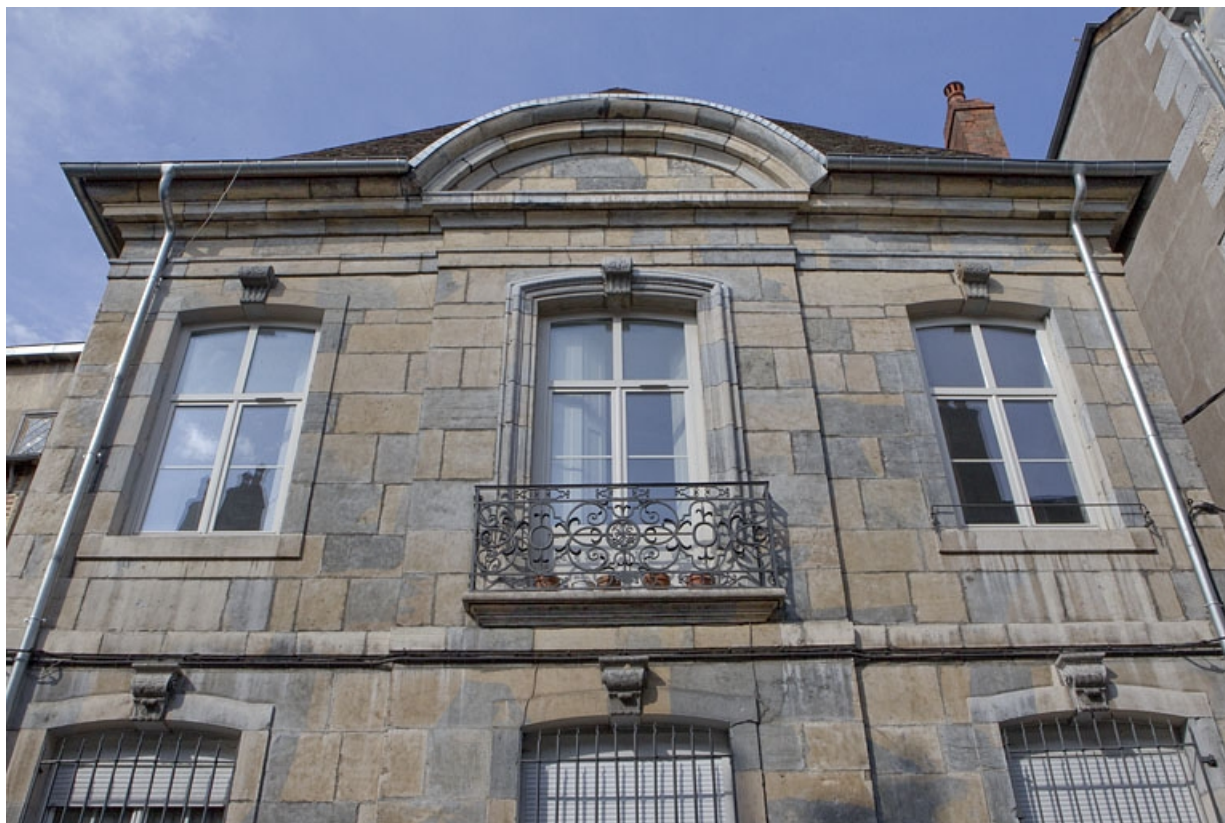
Aile droite : partie supérieure de la façade sur rue surmontée d'un fronton cintré. 25, Besançon, 8 rue des Martelots, lieudit : îlot Saint-Maurice
