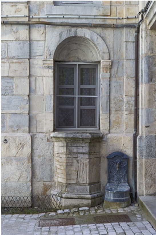
Vue d'ensemble du puits et de la borne fontaine appuyés contre le mur de clôture de la cour. 25, Besançon, 2 place Jean Cornet, lieudit : îlot Saint-Maurice
