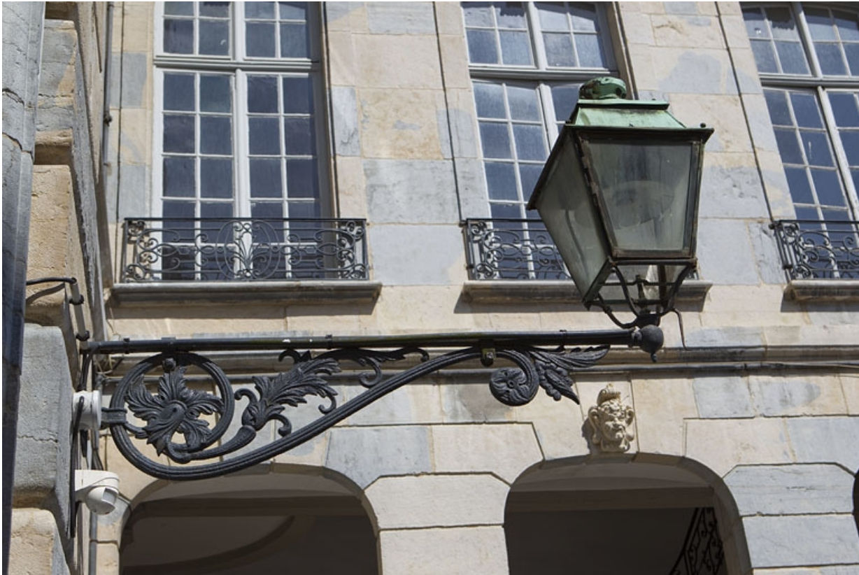
Vue d'ensemble du bec de gaz sur la façade en fond de cour.
