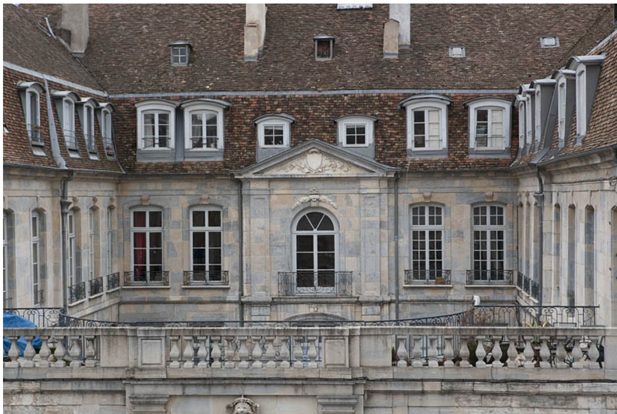
Vue rapprochée en hauteur de la balustrade du mur de clôture et du premier étage des façades sur cour.
