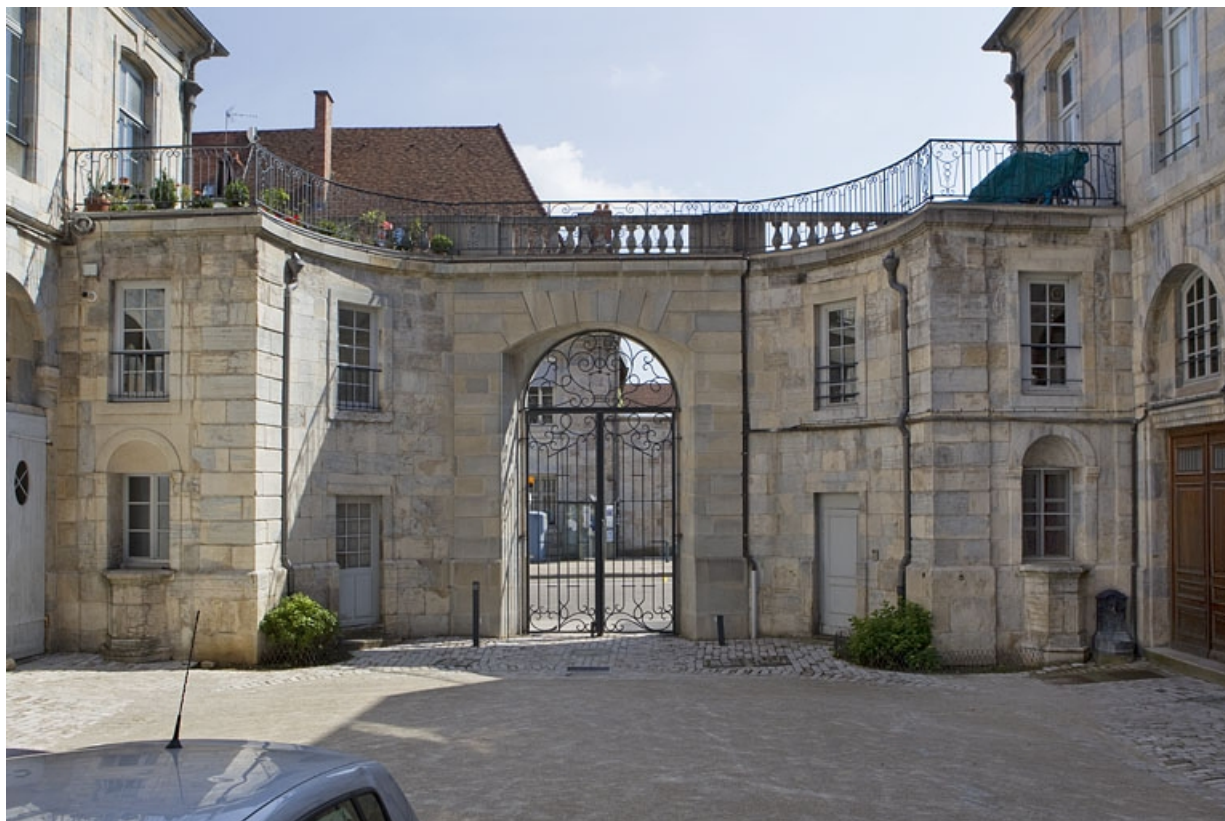
Vue d'ensemble de la clôture sur rue depuis la cour, de face.
