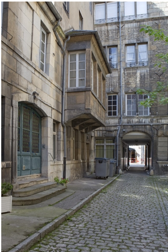
Vue des façades de l'immeuble depuis le fond de la cour, avec le bow-window. 25, Besançon, 92 rue des Granges, lieudit : îlot Saint-Maurice
