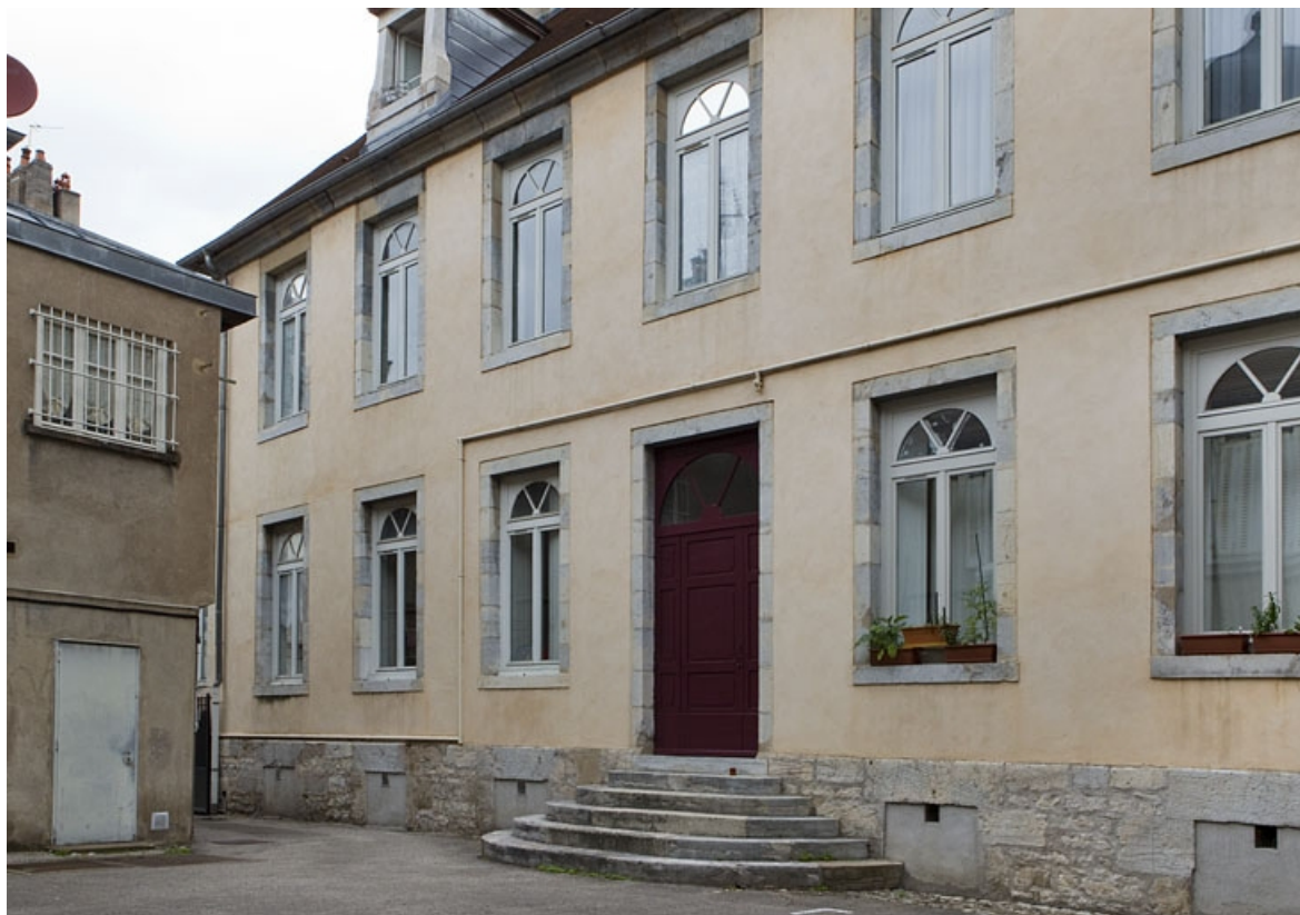
Maison entre les deux cour : façade postérieure de trois quarts droit.
