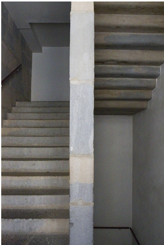
Maison entre les deux cours : détail de l'escalier rampe sur rampe, partie supérieure.
