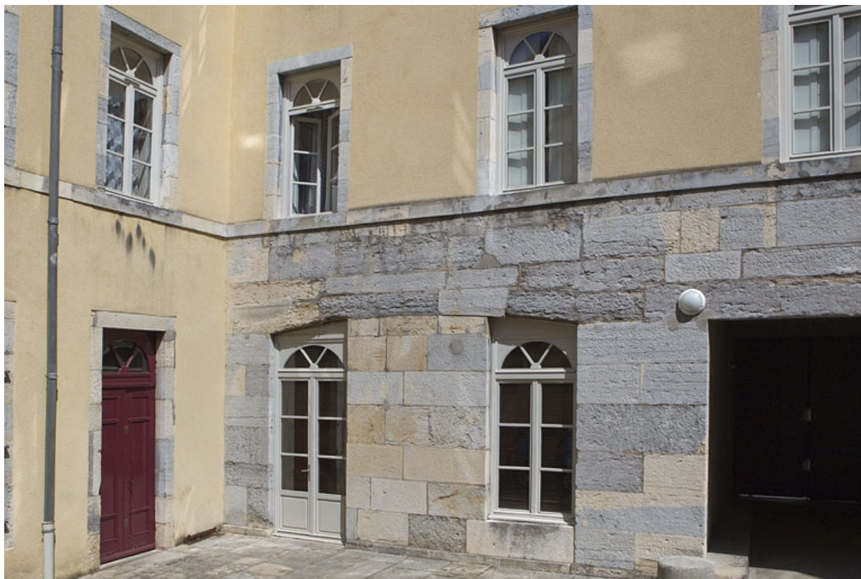
Immeuble : vue des façades sur la première cour à droite du passage cocher. 25, Besançon, 92 rue des Granges, lieudit : îlot Saint-Maurice
