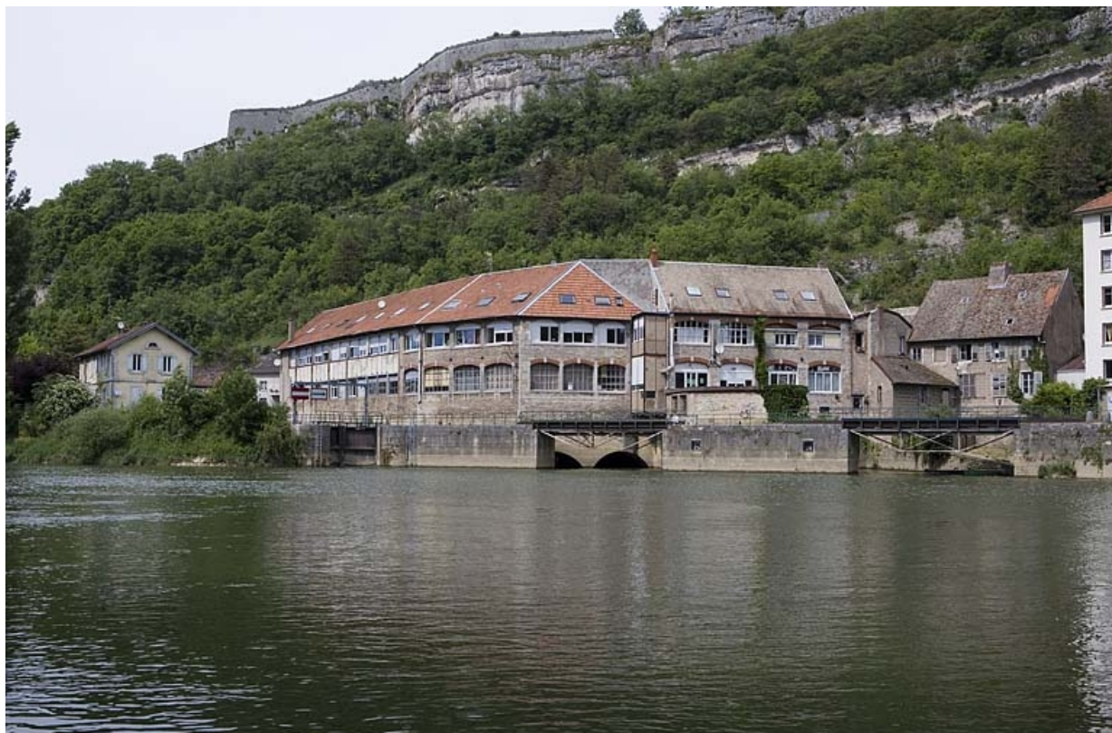
Moulin de Tarragoz : vue d'ensemble côté rivière, depuis l'amont. 25, Besançon
