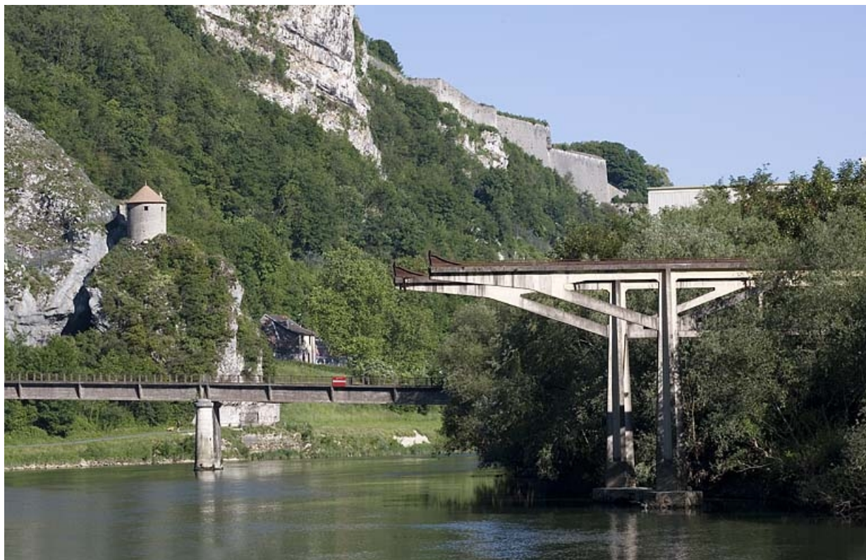
Port de l'usine dite des Soieries puis de la Rhodiacéta : portique en béton du pont roulant.
