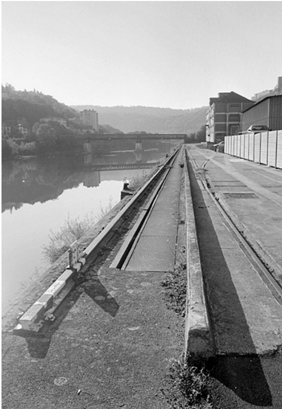
Port fluvial : quai et vestiges de la voie de roulement de la grue mobile, depuis l'aval. 25, Besançon
