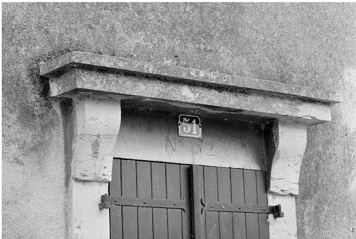
Corniche surmontant la porte d'entrée de la maison d'éclusier. 25, Besançon, 51 chemin de halage Casamène, lieudit : Casamène
