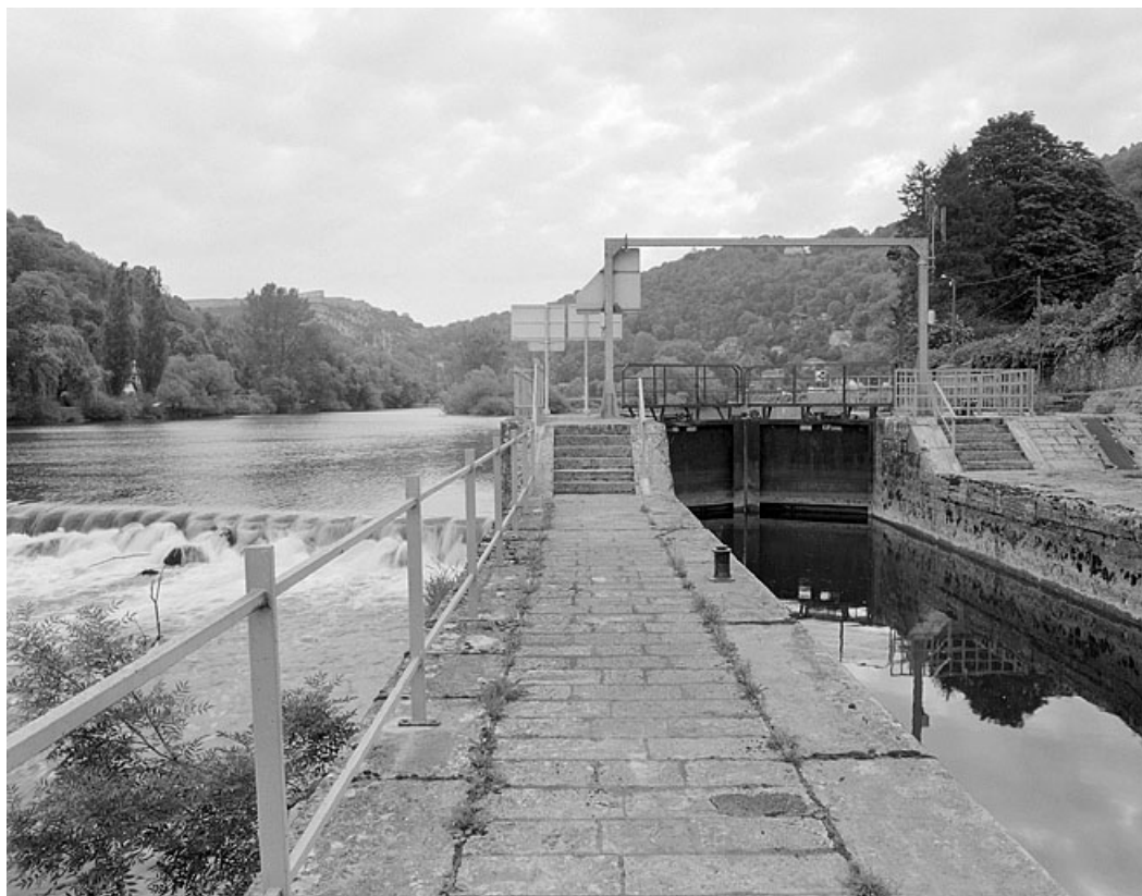
Porte amont de l'écluse et barrage.
