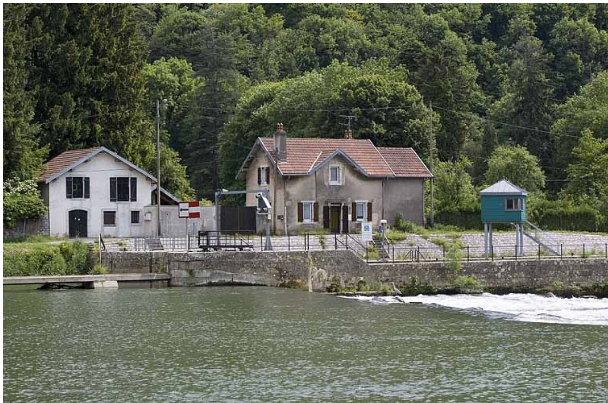
Ancienne écurie, maison, écluse et poste de commande.
