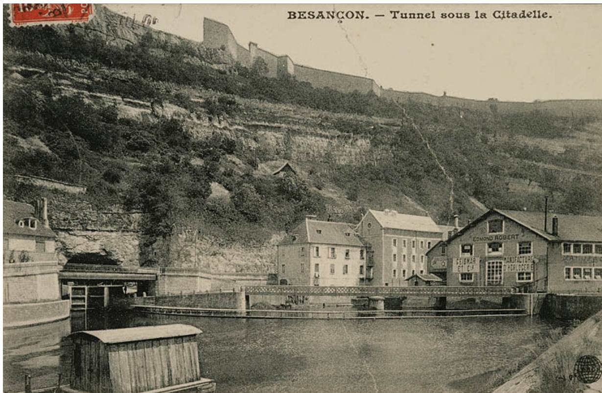
Besançon. - Tunnel sous la Citadelle [depuis l'île de la maison d'éclusier n° 51], décennie 1890 ou 1900. 25, Besançon Faubourg Tarragnoz, lieudit : îlot Tarragnoz
