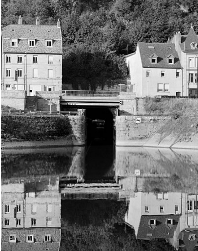
Porte de garde et extrémité amont.
