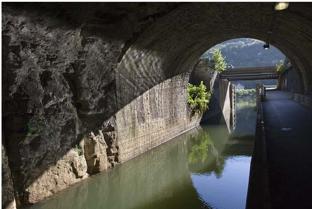
Vue d'ensemble depuis le tunnel.
