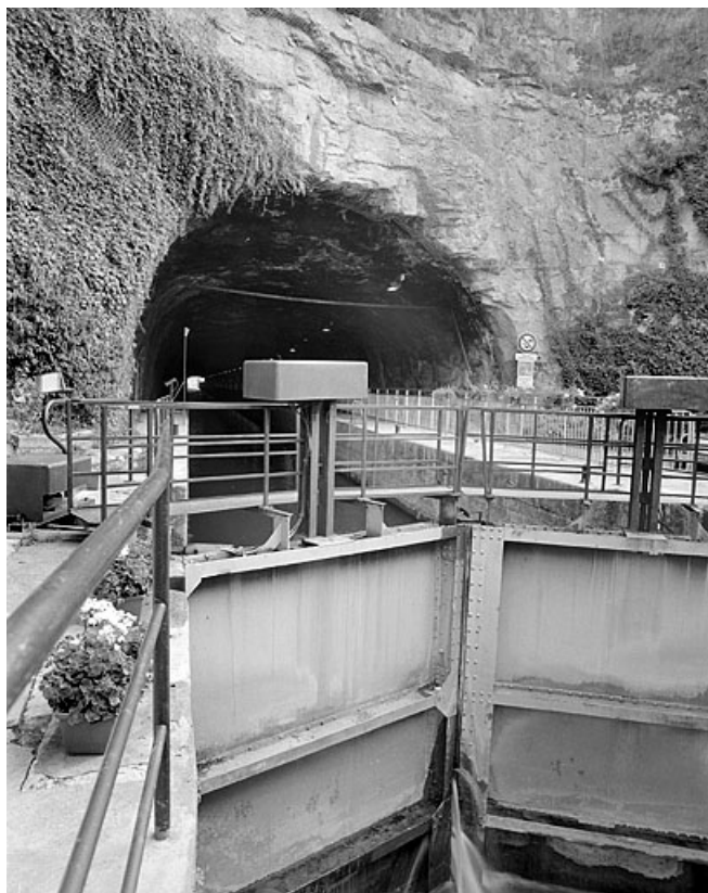
Porte aval de l'écluse et tunnel.
