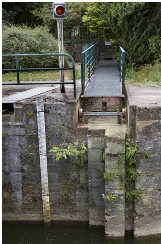
Tête amont de l'écluse : passerelle d'accès à la maison d'éclusier retirée.
