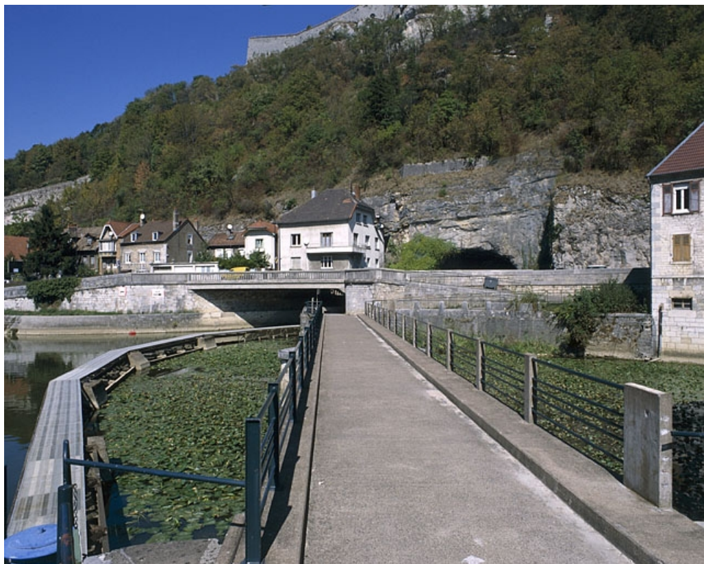
Pont de halage sur le bassin en amont des canaux d'amenée de l'usine, depuis l'écluse n° 51. 25, Besançon Faubourg Tarragnoz 2 à 6, lieudit : îlot Tarragnoz
