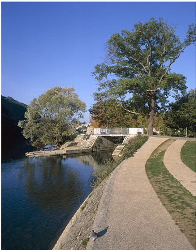
Chemin de halage et débouché du chenal dans le Doubs, depuis l'aval. 25, Besançon avenue de la Gare d'Eau, lieudit : îlot Préfecture
