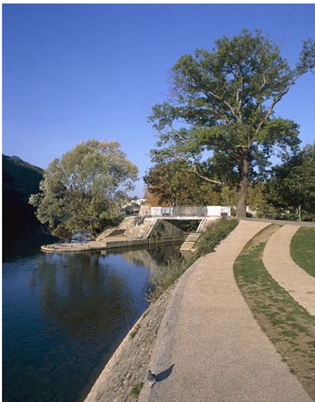
Chemin de halage et débouché du chenal dans le Doubs, depuis l'aval.
