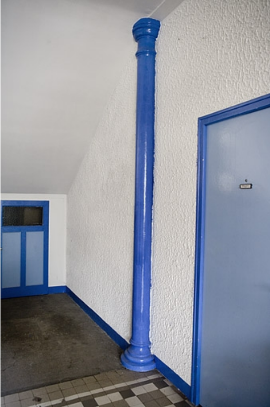
Intérieur de l'entrée : poteau en fonte.
